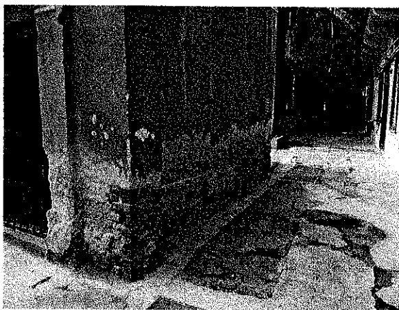
3. és 4. kép: vizesedés-nyomok és vakolatleválás a lábazaton
