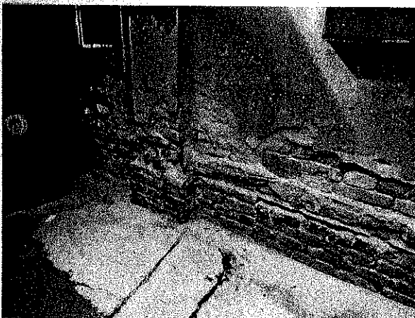
3. és 4. kép: vizesedés-nyomok és vakolatleválás a lábazaton
