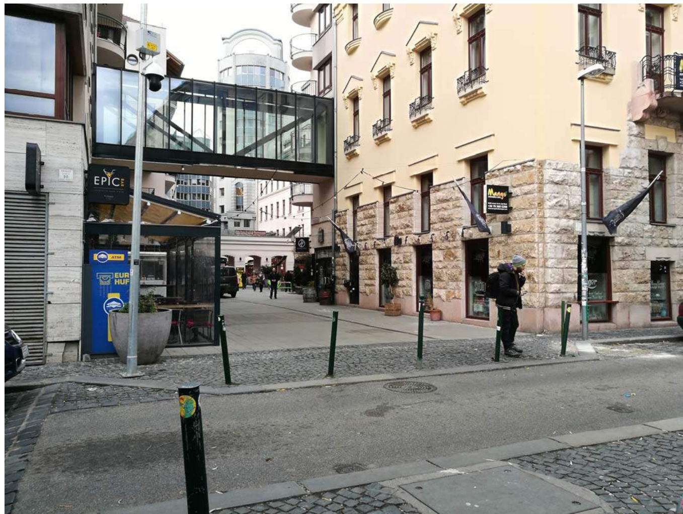
Holló utcai csomópont, szintkiemelés az útfelületen. Csatlakozó bazalt kockakő burkolatú járdák mindkét oldalon.
