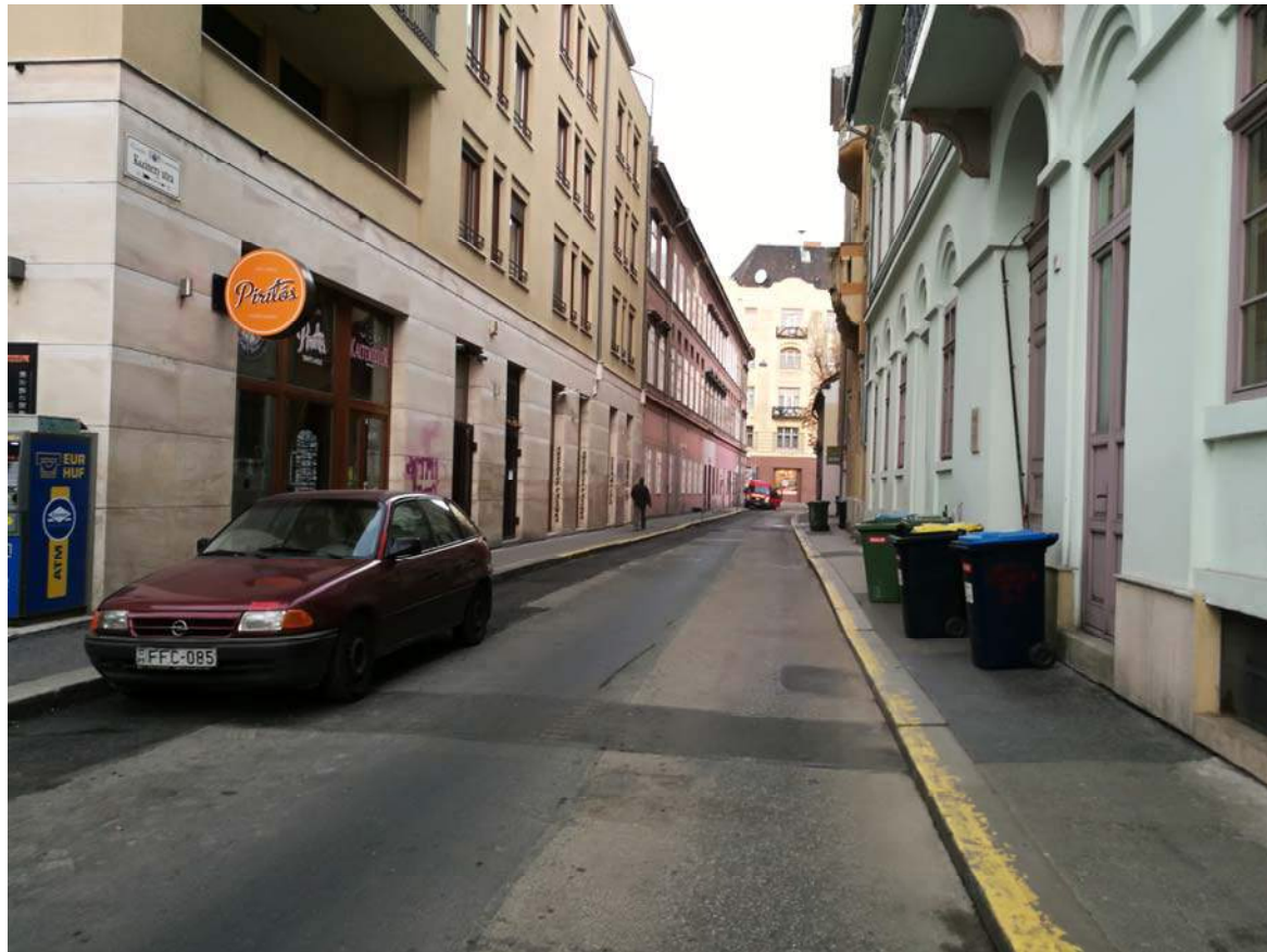
Holló utcával ellentétesen egyirányú Kazinczy utca keresztmetszeti kialakítása: kétoldali aszfalt járda, aszfalt útfelület, szakaszosan biztosított párhuzamos parkolás a szegély mentén az útfelületen, gránit kiemelt útszegély
