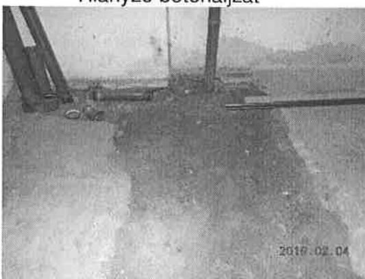
Hiányzó betonajzat
