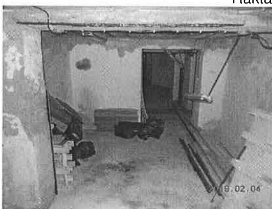
Hiányzó betonajzat
