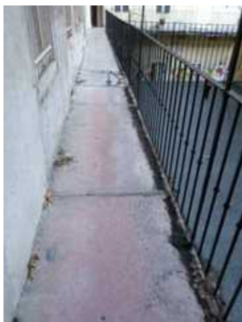
182.-185. A Király utcai szárny I. emeleti szakaszának homlokzati részlete és függőfolyosója – a homlokzati nyíláskiosztások és a függőfolyosó vörös-mészkő lemezszerkezetes DNy-i szakasza, valamint a kovácsoltvas pálcarácsos korlát eredeti építéskori, műemléki értékű szerkezetek. Az kétrétegű, befelé nyíló ablakok silány, újabb nyílászárók. Eredeti bejárati ajtó sem maradt. Csak az egyrétegű lépcsőházi ablak építéskori
