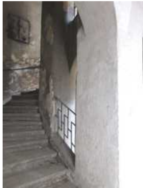
138.-140. A II. emeleti pihenőről a III. emeletre induló lépcső árkádos nyílása és a lépcsőkar alsó szakaszának nézete - a faszerkezetű lépcsőfokokból épített lépcsőkar és orsótér eredeti építéskori (1812), műemléki értékű szerkezetek. Ez a lépcsőkar eredetileg már a padlásra vezethetett, csak később, a 19. sz. közepe táján történt emeletráépítéskor alakították át a III. emelet megközelítését szolgáló lépcsővé. A lépcső oldalfalában elhelyezkedő díszes koromzsák-ajtó is építéskori szerkezet
