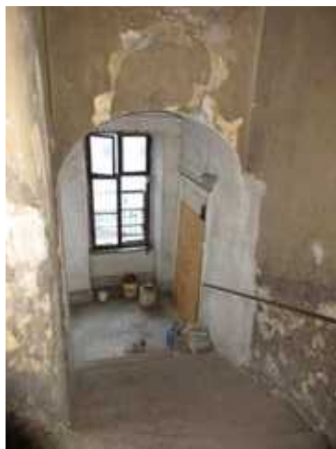
145.-148. A II. emeletről a III. emeletre haladó lépcsőkar középső íves részlete és a II. emeleti lépcsőházi pihenő felülnézete - a fa lépcsőfokokból épített lépcsőkar műemléki értékű szerkezet
