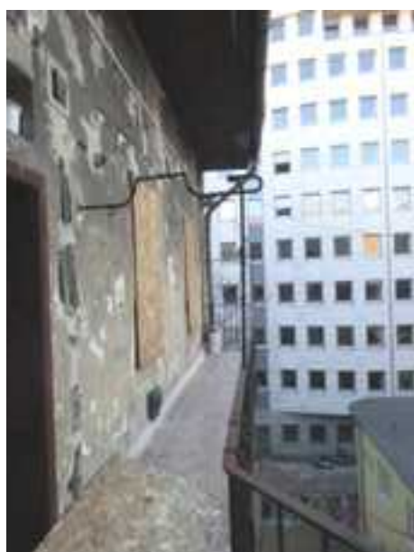
247.-250. Az ÉK-i oldalszárny III. emeleti szakaszának homlokzati nézetei, valamint a függőfolyosó és a sarokban lévő ablak részlete – a homlokzati nyíláskiosztások nagy része és a függőfolyosó kovácsoltvas pálcarácsos korlátja eredeti építéskori, 19. sz. közepe-táján épült műemléki értékű szerkezetek. Az ablakok be vannak deszkázva, a Király utcai és udvari szárny találkozásának ferde falában lévő kétrétegű, ki-be nyíló szárnyú ablaka újabban gyártott nyílászáró, de követi a korabeli klasszicista szerkezetet. A függőfolyosó vb. szerkezetű
