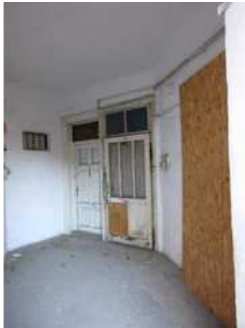
230.-233. A DNy-i oldalszárny III. emeleti szakaszának homlokzati nyílászárói és az oldalszárny és utcai szárny találkozásában lévő bejárat nyílás és előtér – a kétrétegű, ki-be nyíló szárnyú ablak nyílászárója 19. századi
