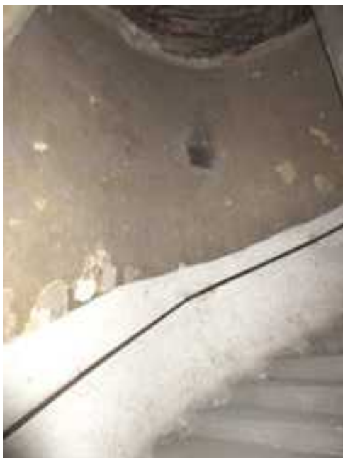
113.,114. Az I. emeletről a II. emeletre induló szürke mészkő szerkezetű lépcső alsó szakaszának bal és jobb oldali oldalfala - a szürke mészkő lépcsőfokokból épített lépcsőkar eredeti építéskori, műemléki értékű szerkezet
