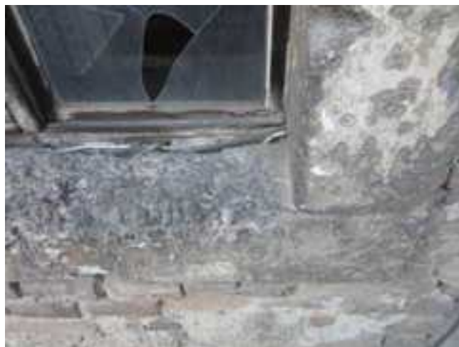
213.-215. Eredeti III. emeleti ablak és a lépcsőházi ablak nézete kőkeretének részletei – a kétrétegű, ki-be nyíló szárnyú, klasszicista szerkezetű ablak 19. századi, műemléki értékű nyílászáró. A lépcsőházi ablak tokkerete még régi, de az ablakszárnyak és vasalatok már újak. A kőkeret 19. századi
