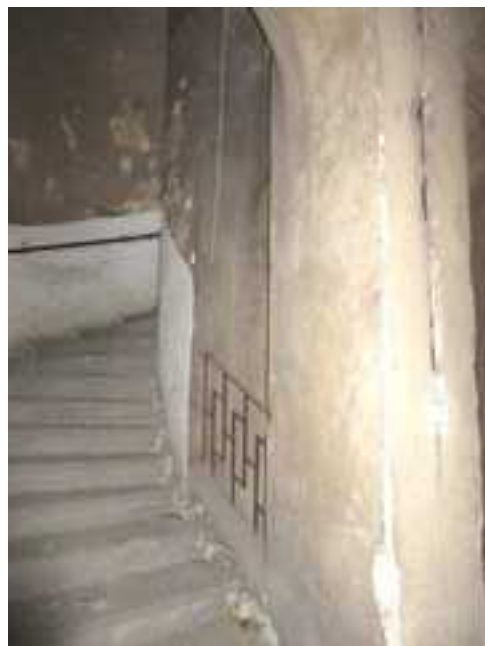
113.,114. Az I. emeletről a II. emeletre induló szürke mészkő szerkezetű lépcső alsó szakaszának bal és jobb oldali oldalfala - a szürke mészkő lépcsőfokokból épített lépcsőkar eredeti építéskori, műemléki értékű szerkezet
