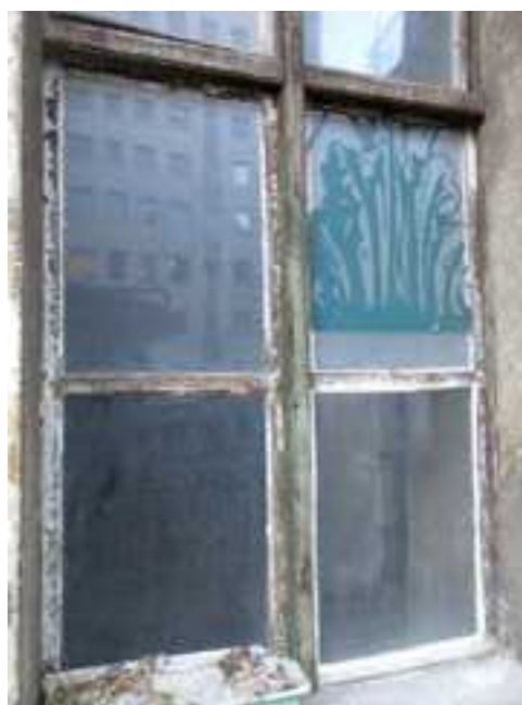
190.-192. Az I. emeleti lépcsőházi ablak nézete és részletei – a kőkeretben elhelyezkedő ablaknyílás és a benne lévő egyrétegű nyílászáró még korabeli, műemléki értékű szerkezet
