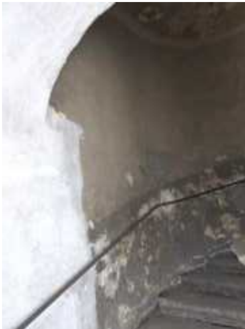
138.-140. A II. emeleti pihenőről a III. emeletre induló lépcső árkádos nyílása és a lépcsőkar alsó szakaszának nézete - a faszerkezetű lépcsőfokokból épített lépcsőkar és orsótér eredeti építéskori (1812), műemléki értékű szerkezetek. Ez a lépcsőkar eredetileg már a padlásra vezethetett, csak később, a 19. sz. közepe táján történt emeletráépítéskor alakították át a III. emelet megközelítését szolgáló lépcsővé. A lépcső oldalfalában elhelyezkedő díszes koromzsák-ajtó is építéskori szerkezet
