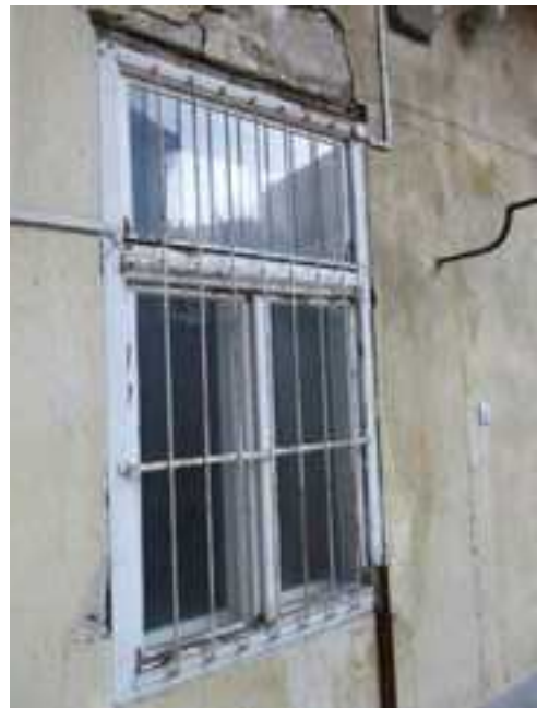
188.,189. I. emeleti ablakok – újabb, igénytelen szerkezetű nyílászárók
