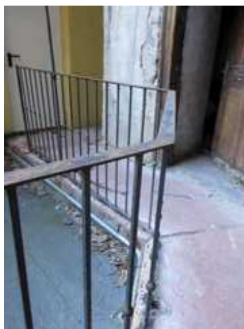
182.-185. A Király utcai szárny I. emeleti szakaszának homlokzati részlete és függőfolyosója – a homlokzati nyíláskiosztások és a függőfolyosó vörös-mészkő lemezszerkezetes DNy-i szakasza, valamint a kovácsoltvas pálcarácsos korlát eredeti építéskori, műemléki értékű szerkezetek. Az kétrétegű, befelé nyíló ablakok silány, újabb nyílászárók. Eredeti bejárati ajtó sem maradt. Csak az egyrétegű lépcsőházi ablak építéskori
