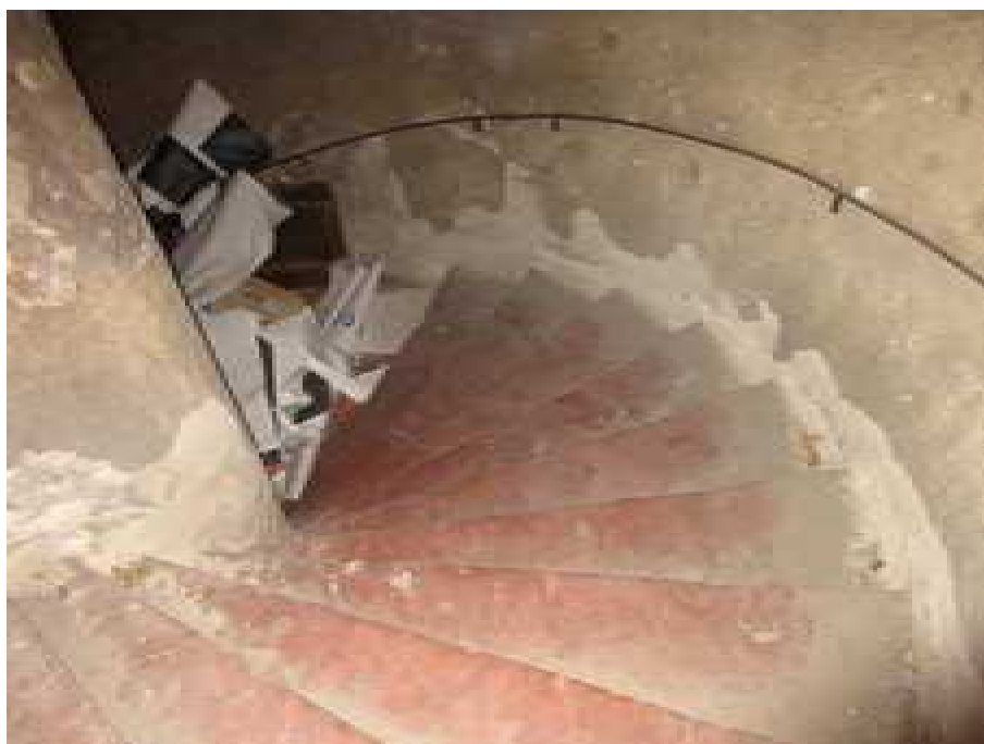
91.-93. A földszintről az I. emeletre haladó lépcsőkar középső íves szakasza és a lépcsőfokok részletei – a vörös-mészkő lépcsőfokokból épített lépcsőkar eredeti építéskori (1812), műemléki értékű szerkezet
