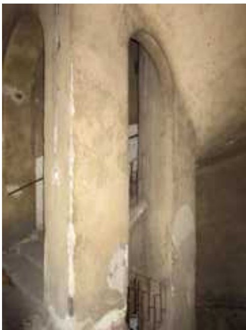
94.,95. A falazott, íves nyílásokkal áttört orsótér és a lépcső vakolt alsó felületének a nézete – műemléki értékű kialakítás és szerkezet
