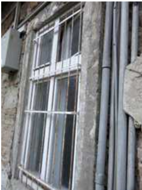
188.,189. I. emeleti ablakok – újabb, igénytelen szerkezetű nyílászárók
