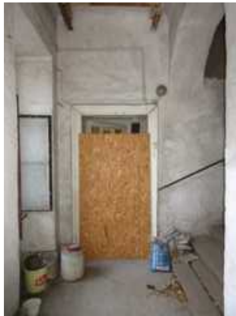
128.,129. A II. emeleti lépcsőházi pihenő ÉK-i és DNy-i oldalfalának nézete és a lakásbejárati ajtókkal – a pihenő szerkezeti kialakítása építéskori, műemléki értékű szerkezet. A lakásbejárati ajtók tagozatos tokkerete még korabeli, de a bennük lévő nyílászárók új szerkezetek
