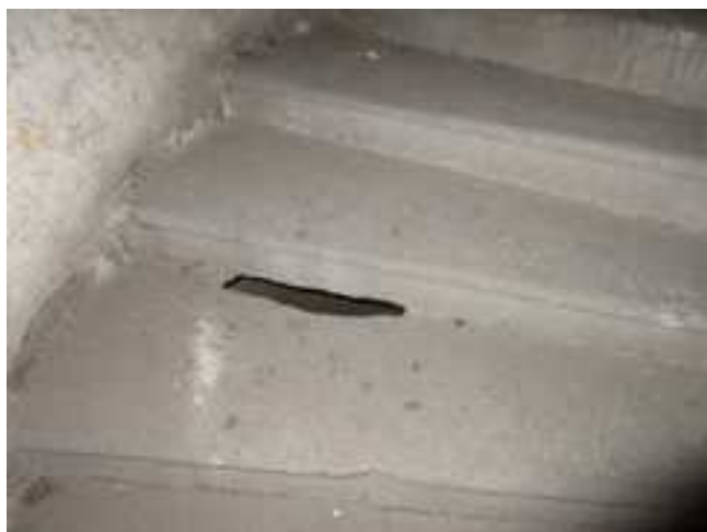
119.,120. A szürke mészkő szerkezetű lépcső részlete a kitöréssel és a lépcsőkar sérült mennyezetének a nézete – a lépcső eredeti építéskori szerkezet
