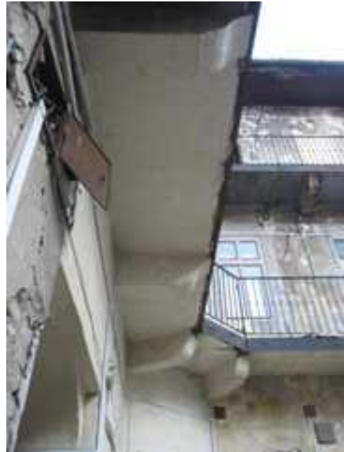
186.,187. Az I. emelet fölötti függőfolyosó nézetei – a kőkonzolok eredetiek, de a lemez már vasbetonból készült és néhány konzolt nem építettek vissza
