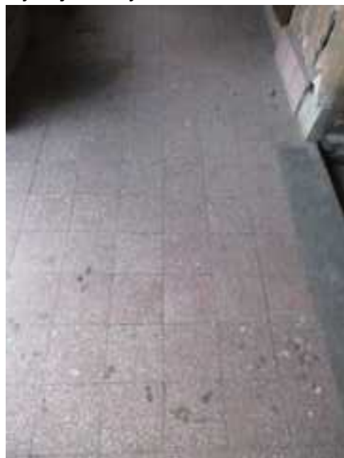
161.,162. A III. emeleti pihenő födémének és járófelületének a nézetei – a síkfödém 19. sz. közepi, de az acélkeretes megerősítés az 1960-as években készült. A rózsaszín cementlap burkolat feltehetően az 1960-as évek végén, a függőfolyosók lemezének a cseréje során készült
