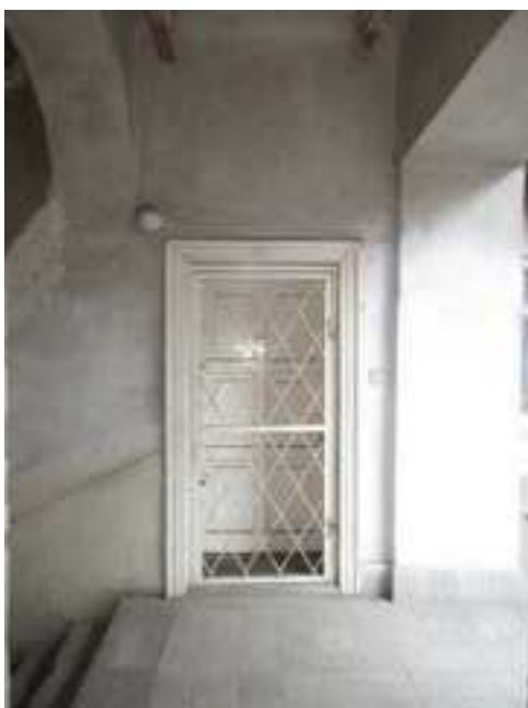
128.,129. A II. emeleti lépcsőházi pihenő ÉK-i és DNy-i oldalfalának nézete és a lakásbejárati ajtókkal – a pihenő szerkezeti kialakítása építéskori, műemléki értékű szerkezet. A lakásbejárati ajtók tagozatos tokkerete még korabeli, de a bennük lévő nyílászárók új szerkezetek
