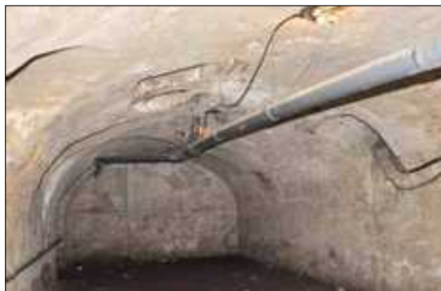
Csatornavezeték a pincében
