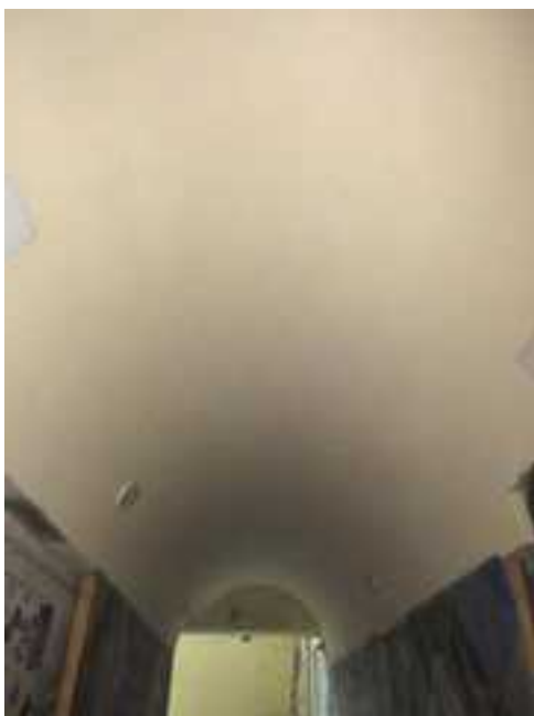
76.,77. A kapualj boltozatának és padlóburkolatának a nézete – a kapualj eredeti födémét eltakaró dongaboltozatos áll-burkolat utólagos, zavaró és megtévesztő megoldás. A jelenlegi sárgás térkő burkolat sem eredeti, 2010 után készült, nem túl igényes burkolat
