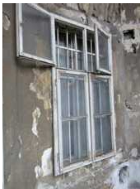
247.-250. Az ÉK-i oldalszárny III. emeleti szakaszának homlokzati nézetei, valamint a függőfolyosó és a sarokban lévő ablak részlete – a homlokzati nyíláskiosztások nagy része és a függőfolyosó kovácsoltvas pálcarácsos korlátja eredeti építéskori, 19. sz. közepe-táján épült műemléki értékű szerkezetek. Az ablakok be vannak deszkázva, a Király utcai és udvari szárny találkozásának ferde falában lévő kétrétegű, ki-be nyíló szárnyú ablaka újabban gyártott nyílászáró, de követi a korabeli klasszicista szerkezetet. A függőfolyosó vb. szerkezetű
