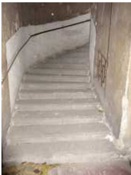
A II. emeletre haladó szürke mészkő és a III. emeletre haladó faszerkezetű lépcsőkar nézetei
