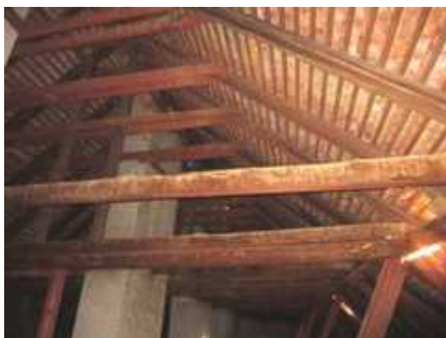
267.-271. A Király utcai épületszárny fölötti tetőszerkezet nézetei – bár az utóbbi években a tetőszerkezetet javították és megerősítették, fő szerkezeti elemei a 19. század közepén épültek. A késő-klasszicista, feszítőműves fedélszék műemléki értéket képvisel
