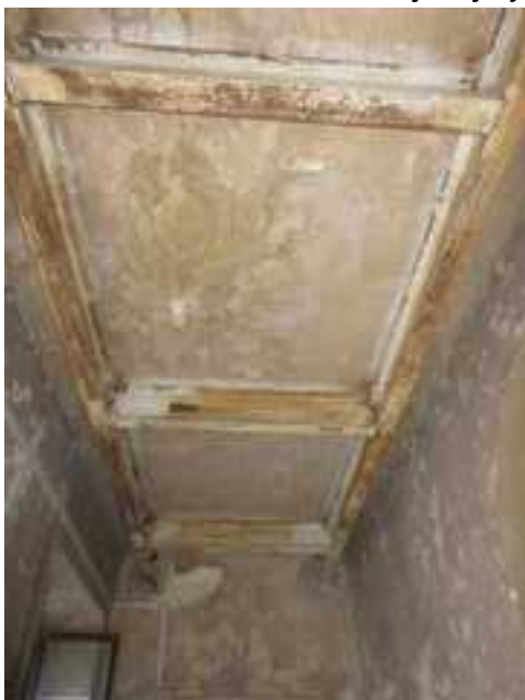
161.,162. A III. emeleti pihenő födémének és járófelületének a nézetei – a síkfödém 19. sz. közepi, de az acélkeretes megerősítés az 1960-as években készült. A rózsaszín cementlap burkolat feltehetően az 1960-as évek végén, a függőfolyosók lemezének a cseréje során készült
