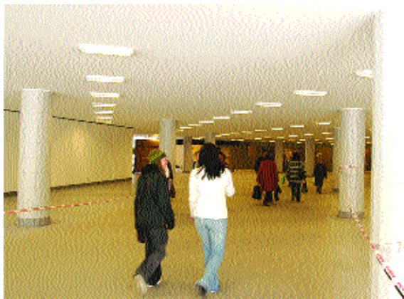
Az új aluljáró korszerű burkolatot és kivilágítást kapott
