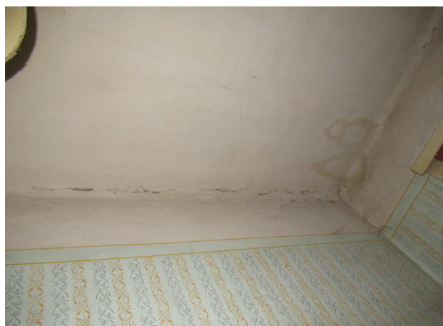
repedés és beázás nyoma a mennyezeten
