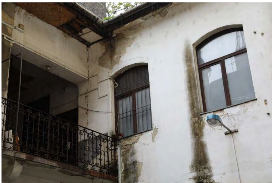
beázási nyomok a homlokzaton és a sarokban lévő repedés
