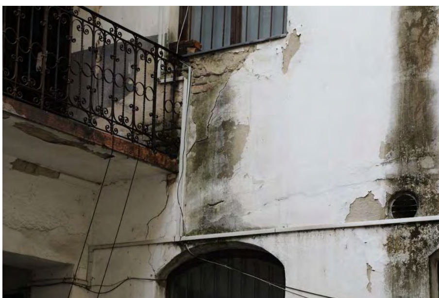
Csapadékvíz okozta homlokzati fal károsodás
