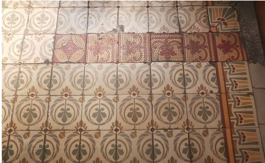
A külső előtér burkolata, javításokkal.
