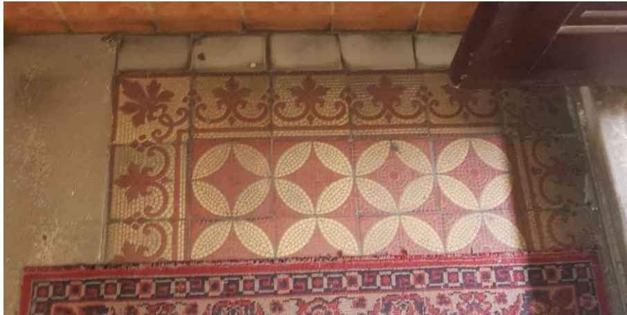
Előtér belső-felső részének padlóburkolata.
