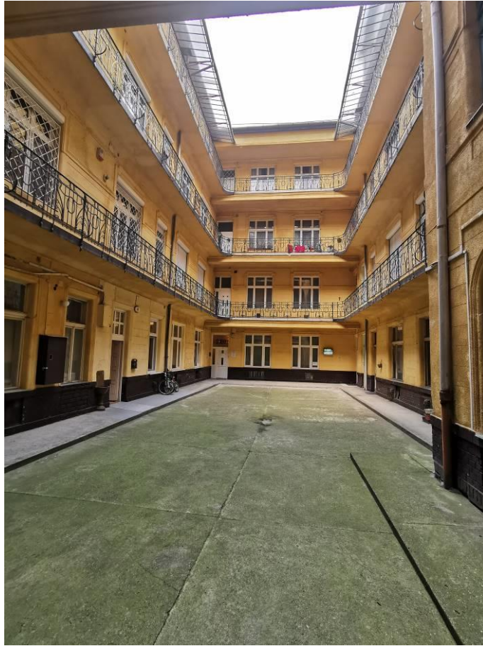
Az udvar a bejárat felől nézve.
