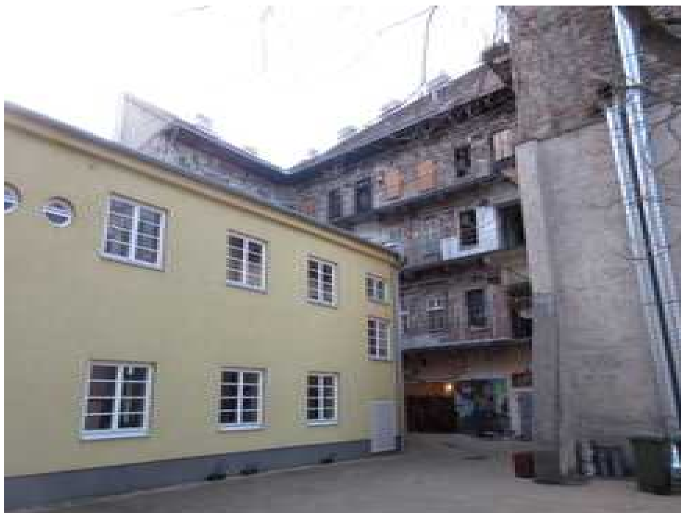
163. A Király u. 11. sz. épület udvari homlokzatainak nézete DK felől - az erősen elhanyagolt udvari homlokzatok viszonylag jól megőrizték eredeti klasszicista, 1812-es kialakításukat, a 19. sz. közepén történt emeletráépítés a korábbi homlokzathoz illeszkedett, annak kialakítását teljes mértékben követte
