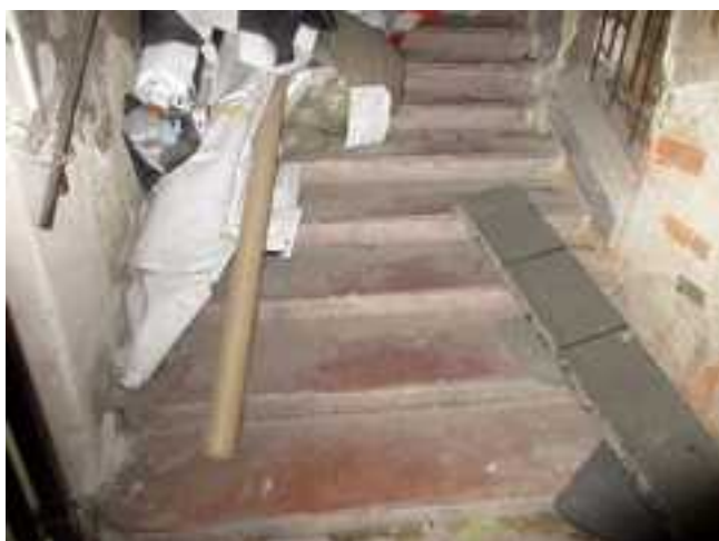
87.-90. A földszintről az I. emeletre haladó lépcsőkar alsó szakasza és a lépcsőfokok részletei – a vörös-mészkő lépcsőfokokból épített lépcsőkar eredeti építéskori (1812), műemléki értékű szerkezet
