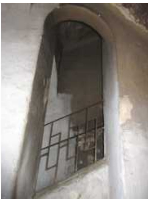
121.-124. Az I. emeletről a II. emeletre haladó lépcsőkar felső, a II. emeleti pihenőre érkező részlete, valamint az íves nyílásokkal áttört orsótér nézetei - a szürke mészkő lépcsőfokokból épített lépcsőkar és orsótér eredeti építéskori, műemléki értékű szerkezetek. Az orsótér nyílásaiban lévő jelenlegi fém korlát újabb szerkezet
