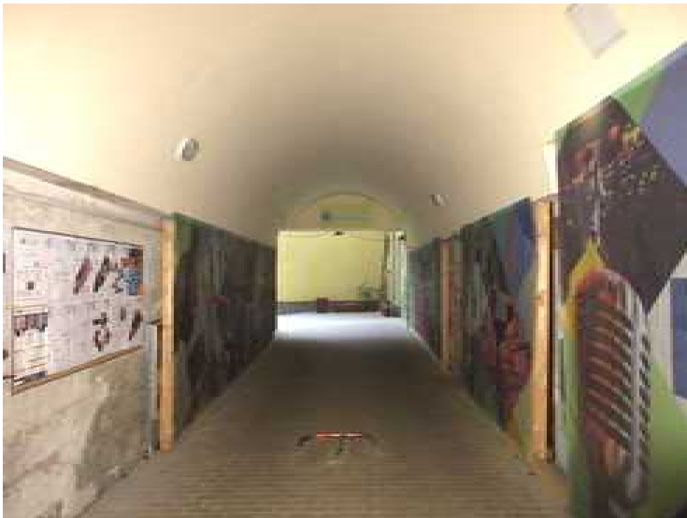
66.,68. A kapualj nézete az utca és az udvar felé - a kapualj oldalfalait molinók takarják, a földémet pedig egy dongaboltozatot imitáló doboz-szerű burkolat alkotja. A kapualj földémét eltakaráó burkolat alatt minden bizonnyal még meg van az archív terveken ábrázolt eredeti építéskori, hevederekkel tagolt csehsüveg boltozatos földém. a boltozattal fedett kapualj kialakítása és szerkezete 1812-ben készült, műemléki értékű szerkezet
