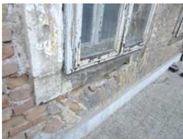
203.-206. Kőkeretben elhelyezkedő II. emeleti 19. századi ablak nyílászárójának részletei – műemléki értékű nyílászáró. Egy felújítás esetén e nyílászáró mintája alapján lehet újragyártani az udvari ablakokat
