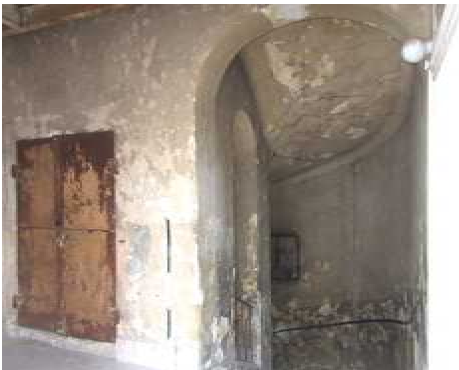
153. A III. emeleti pihenő ÉNy-i oldalfala a padlásra vezető ajtóval és a lépcső érkezési árkádívével - a III. emeleti pihenő a 19. sz. közepe táján épült, műemléki értékű szerkezet és kialakítás. A fém padlásajtó 20. sz. eleji szerkezet
