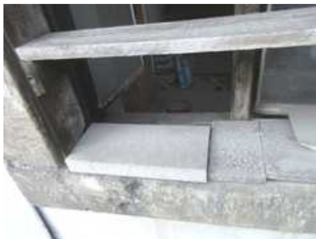
207.,208. A II. emeleti lépcsőházi ablak részlete - az ablak tokkerete még régi, de az ablakszárnyak és vasalatok már újak. Jól látható az ablaknyílás kőkerete
