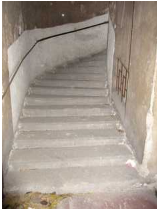
110.-112. Az I. emeletről a II. emeletre induló szürke mészkő szerkezetű lépcsőkar kosáríves árkádja és a lépcső részlete - a szürke mészkő lépcsőfokokból épített lépcsőkar eredeti építéskori (1812), műemléki értékű szerkezet
