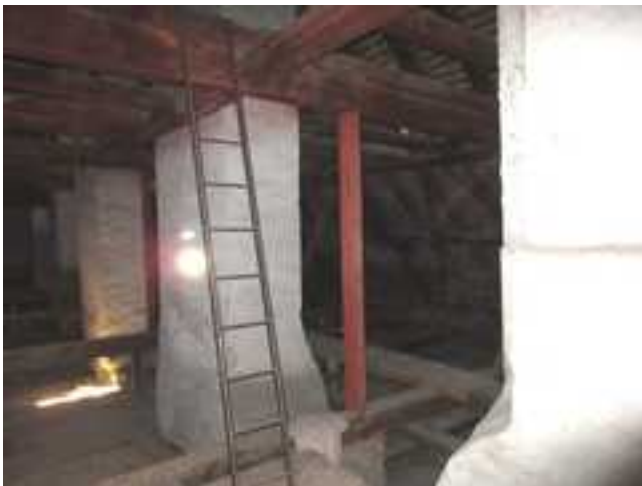
265.,266. Az utcai szárny padlásterében sorakozó kémények és az elhúzott, íves kémény
