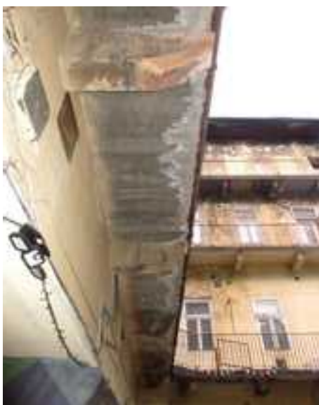
177.-181. Földszinti ablakok és ajtó részlete, pince lejárata és az I. emeleti függőfolyosó alulnézetei – az ablaknyílás és a felülvilágító körkeretes ajtónyílás új, nem eredeti. A pincelejárata utólagos, a függőfolyosó kőkonzolja építéskori, de a vb. lemez új
