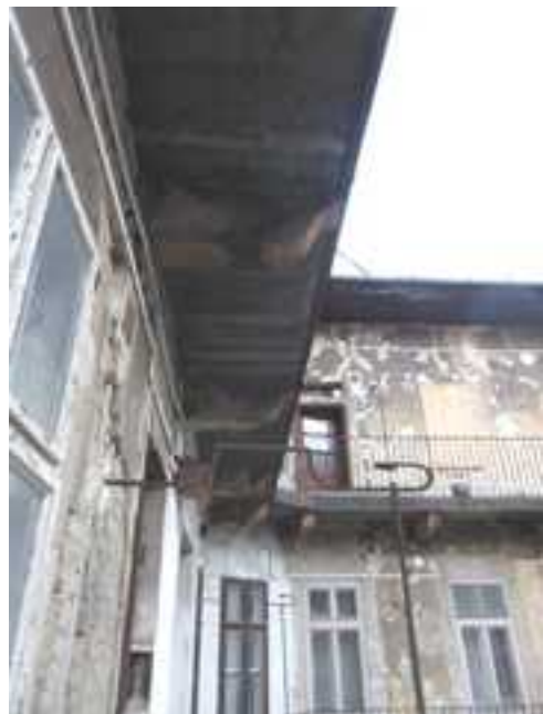
195.-198. A II. emeleti függőfolyosó és a fölötté lévő konzolos függőfolyosó nézetei DNy és ÉK felé – a vasbeton lemezes függőfolyosón szürke cementlap burkolat van, az eredeti vörös-mészkeő lemez cseréje az 1960-as évek végén történt, ekkor az eredeti kőkonzolokat csak részben helyezték vissza
