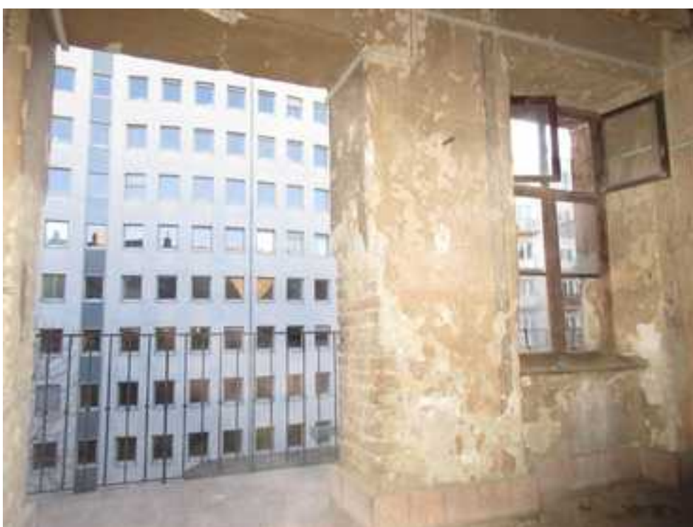
154. A III. emeleti lépcsőházi pihenő udvarral határos DK-i oldalfala a függőfolyosóra vezető egyenes záradékú ajtónyílással és ablakkal – a III. emeleti pihenő a 19. sz. közepe táján épült, műemléki értékű szerkezet és kialakítás. Az ablak tokkerete még korabeli, de az ablakszárnyak már újabbak
