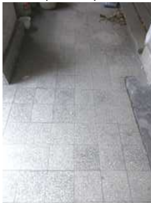
130.,131. A II. emeleti pihenő födémének és járófelületének a nézetei – a síkfödém építéskori, de az acélkeretes megerősítés az 1960-as években készült. A szürke cementlap burkolat nem építéskori, feltehetően az 1960-as évek végén, a függőfolyosók lemezének a cseréje során készült
