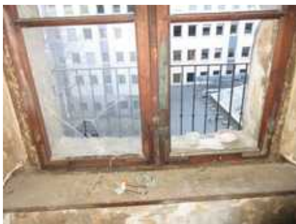
156.-158. A III. emeleti lépcsőházi ablak nézete és részletei – az ablaknyílás és a tokkeret a 19. sz. közepe táján készült, a benne lévő nyílászáró már újabb szerkezet. Az ablaknyílás bal oldalán díszítőfestés töredéke látható
