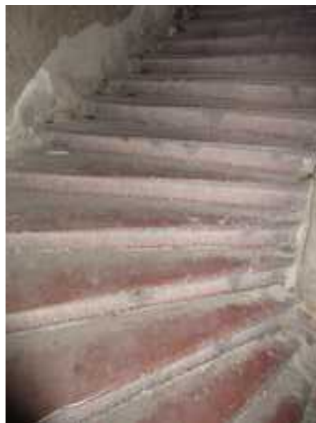
A lépcsőházi földszinti előtér az íves falfülkével és az I. emeletre vezető vörös-mészkő lépcsőkar
