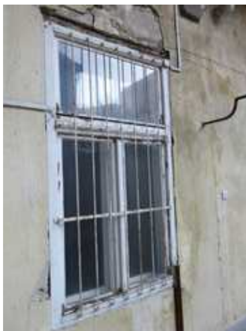
188.,189. I. emeleti ablakok – újabb, igénytelen szerkezetű nyílászárók
