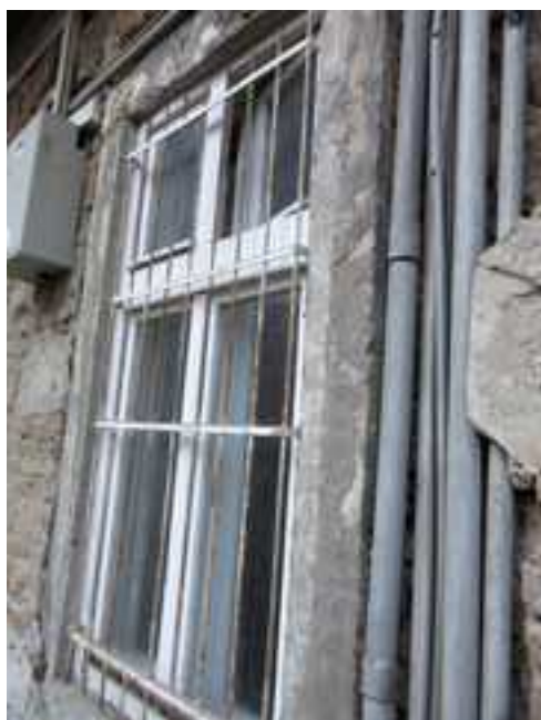
188.,189. I. emeleti ablakok – újabb, igénytelen szerkezetű nyílászárók
