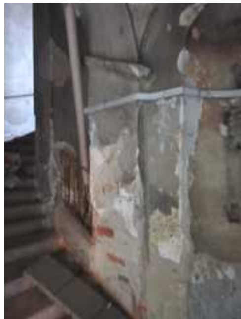
84.-86. Az előtérből a földszinti lépcsőkar felé vezető vállköves, félpilléres kialakítású kosáríves nyílás nézetei – eredeti építéskori, műemléki értékű kialakítás és szerkezet
