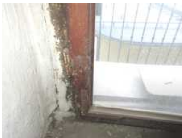
132.-137. A II. emeleti pihenő udvarral határos DK-i oldalfala a függőfolyosóra vezető egyenes záradékú nyílással és ablakkal – eredeti építéskori, műemléki értékű szerkezet és kialakítás. Az ablak tokkerete még építéskori, de az ablakszárnyak már újabbak, a körfordító még korabeli
