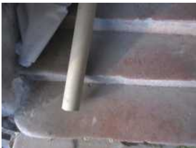
87.-90. A földszintről az I. emeletre haladó lépcsőkar alsó szakasza és a lépcsőfokok részletei – a vörös-mészkő lépcsőfokokból épített lépcsőkar eredeti építéskori (1812), műemléki értékű szerkezet
