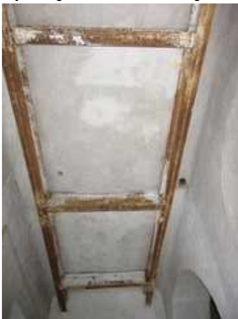
130.,131. A II. emeleti pihenő födémének és járófelületének a nézetei – a síkfödém építéskori, de az acélkeretes megerősítés az 1960-as években készült. A szürke cementlap burkolat nem építéskori, feltehetően az 1960-as évek végén, a függőfolyosók lemezének a cseréje során készült
