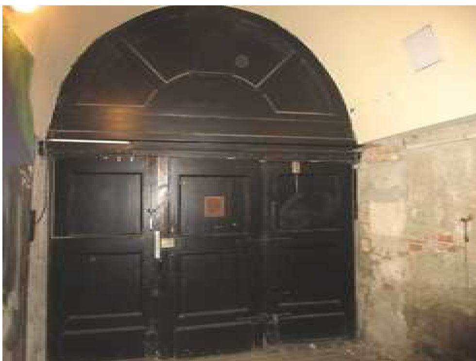
58.,59. A bejárati kapu külső és belső nézete - a félköríves záradékú, felülvilágítós, vésett betétes kétszárnyú bejárati kapu asztalos-szerkezete és vasalatai 1958-ban készültek. Bár a kapu nem eredeti építéskori, de klasszicizáló megjelenésével és igényes kialakításával történeti értékű nyílászáró
