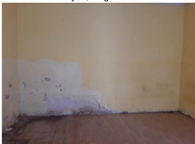
falakon felhúzódó vizesedés nyomai látszik
