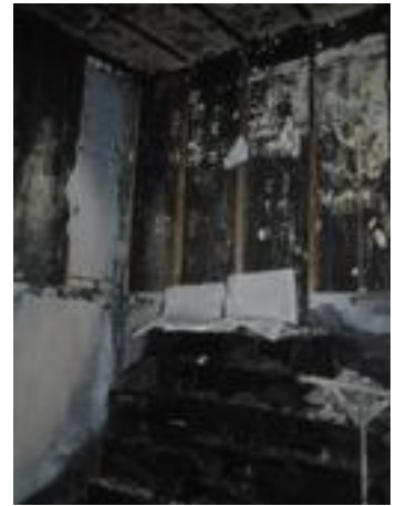
égett vakolat, vakolathibák a falszerkezeten
