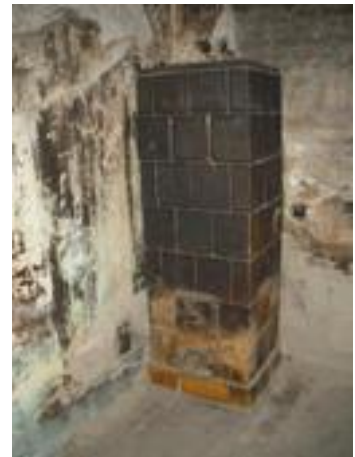
cserépkályha és égett vakolat, vakolathibák a falszerkezeten
