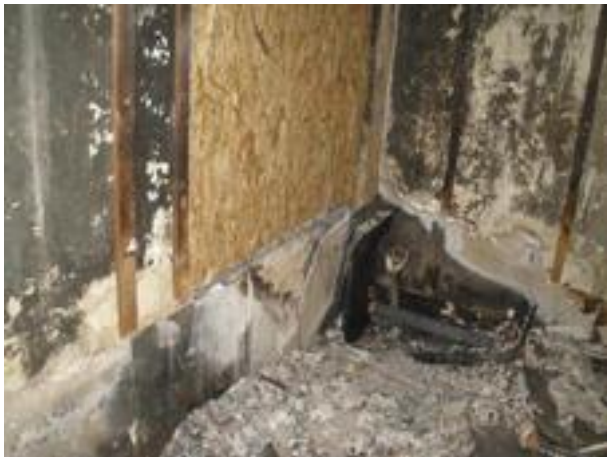
égett vakolat, vakolathibák a falszerkezeten
