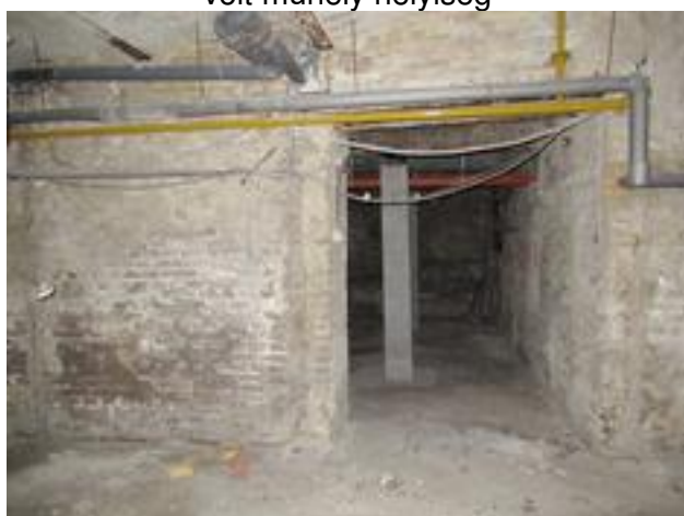
hátsó raktár– alátámasztott földem
