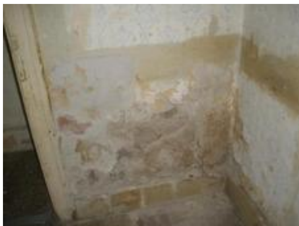
vakolathibák a falszerkezeten
