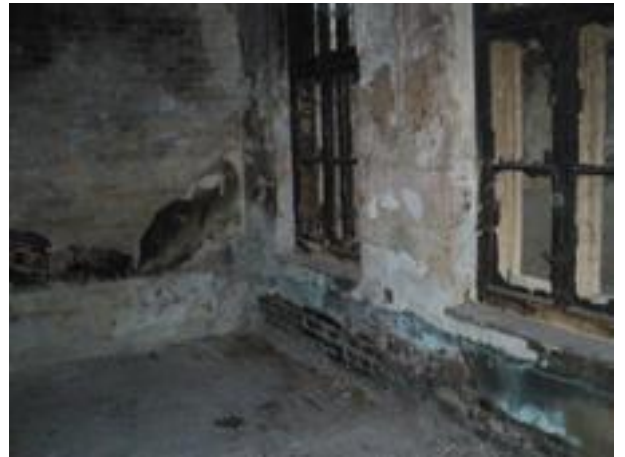
megégett vakolat, vakolathibák a falszerkezeten
