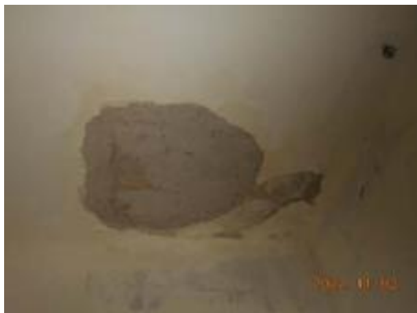
vakolathibák a falszerkezeten
