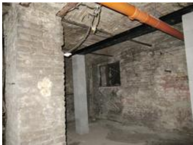
hátsó raktár – alátámasztott földém
