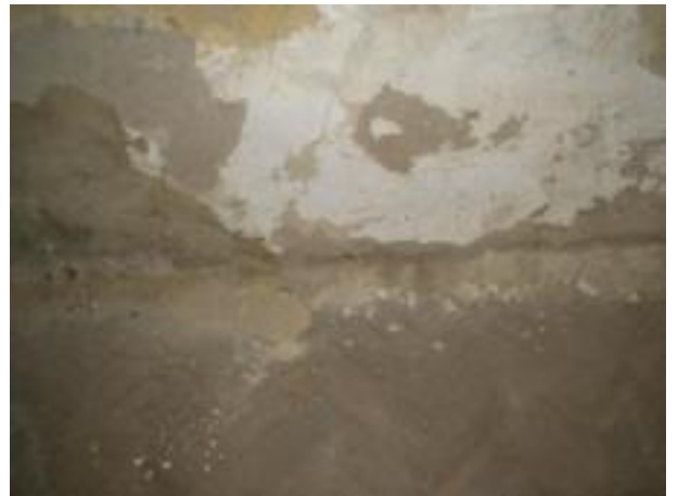
vakolathibák a falszerkezeten
