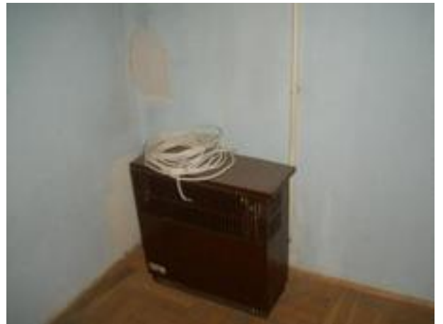
gázkonvektor, vakolathibák javítása a falszerkezeten
