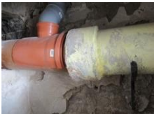
lépcső melletti búvótér – közös szennyvízlefolyó
