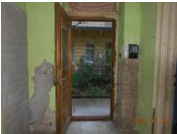
vakolathibák a falszerkezeten
