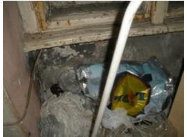
vakolatleválás a falszerkezeten
