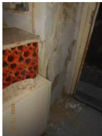
vakolathibák a falszerkezeten
