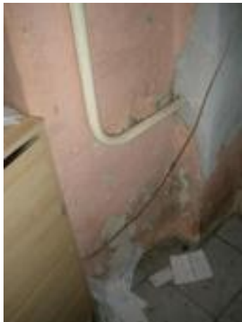
vakolatleválás a falszerkezeten
