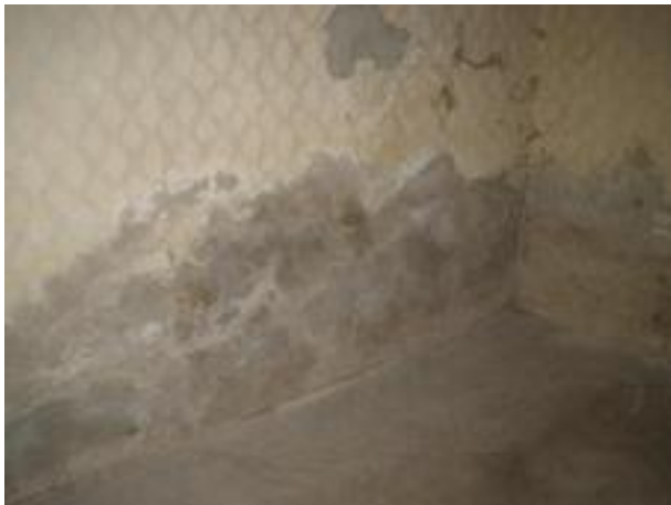
vakolathibák a falszerkezeten
