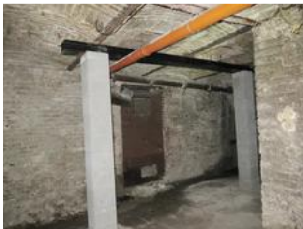
hátsó raktár – alátámasztott földém
