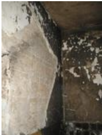
megégett vakolat, vakolathibák a falszerkezeten
