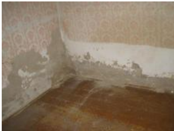
vakolathibák a falszerkezeten
