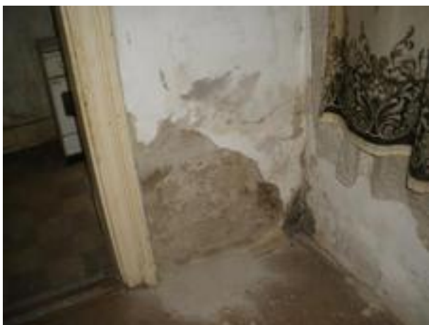
vakolathibák a falszerkezeten
