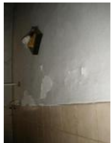
festés leválása a falszerkezeten
