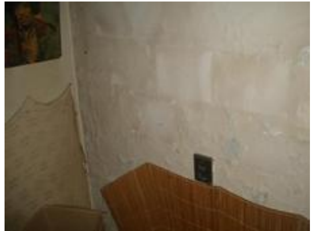
festés leválása a falszerkezeten, beázás nyoma
