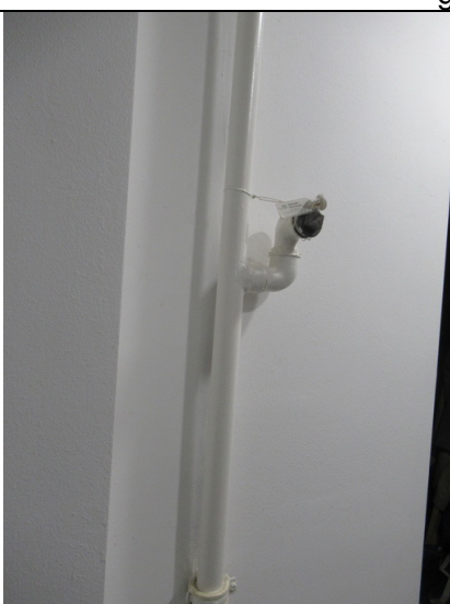
gázbekötés / mérő leszerelve
