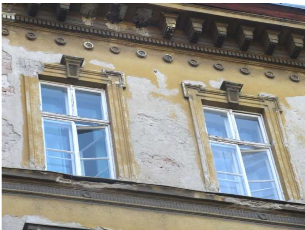
69.,70. III. emeleti új és régi ablak - a homlokzat III. emeletének 1, 2 és 3 tengelyében új ablakok vannak, a többi tengelyben még megvannak az eredeti építéskori, műemléki értékű nyílászárók
