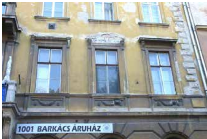
37.-39. A homlokzat I. emeleti szakaszai (ball, közép és jobb) – eredeti építéskori, műemléki értékű nyíláskiosztás és neoreneszánsz tagozati díszítések, kőerkély és korlát kőpillére. A kovácsoltvas korlát már nem eredeti, valószínűleg az 1960-as évek elején történt felújításkor készült
