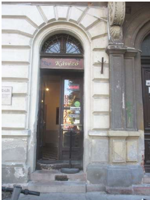
19.,20. A homlokzat 3. axisában elhelyezkedő bejáratú ajtó nézete és az ajtó felülvilágítójának a részlete – a félköríves bejáratú nyílás építéskori kialakítás, a benne lévő ajtó asztalos-szerkezete új. A felülvilágító és a vízszintes tokosztó eredeti szerkezet, a sugaras kiosztású kovácsoltvas rácsozat korabeli szerkezet
