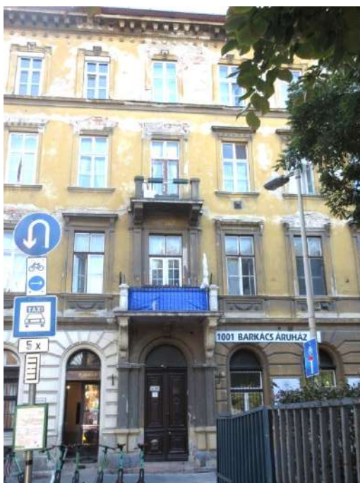
5.-7. A homlokzat függőleges tengelyeinek részletei – a főhomlokzat viszonylag jól megőrizte 1874-ben kialakított neoreneszánsz megjelenését, lényegesebb változások és átalakítások csak a földszinti szakaszon történtek
