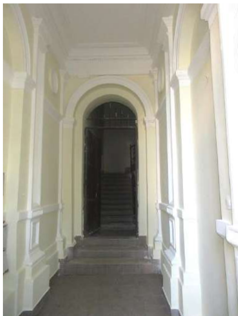
120.,121. A kapualj nézete a lépcsőház és a tér felé - a tükrös kialakítású síkmennyezetes, fejezetes lizénákkal tagolt, stukkódíszes kapualj kialakítása és szerkezete, valamint tagozati díszítései 1874-ben készült, műemléki értékű szerkezetek és díszítőelemek
