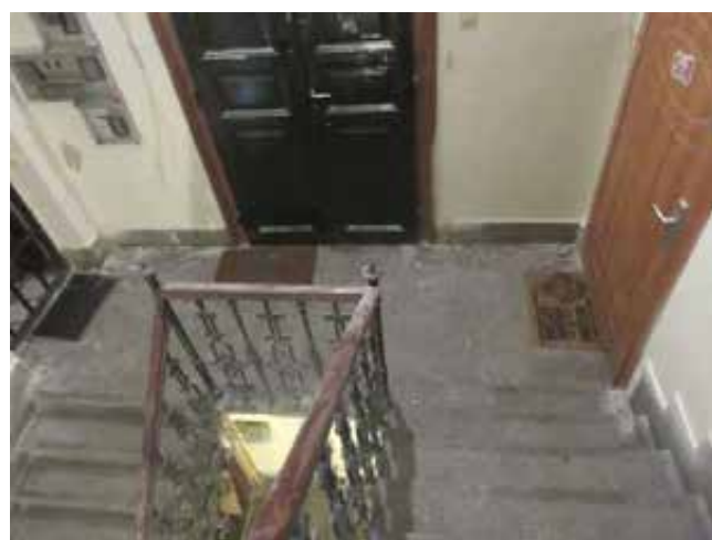
163.-166. A II. emeleti pihenőn elhelyezkedő lakásbejáratok és a pihenő felülnézete – a pihenő két oldaláról nyíló egyszárnyú lakásbejáratok új, igénytelen nyílászárók, csak a középső, ÉNy-i falon álló kétszárnyú ajtó nyílása és nyílászárója eredeti építéskori
