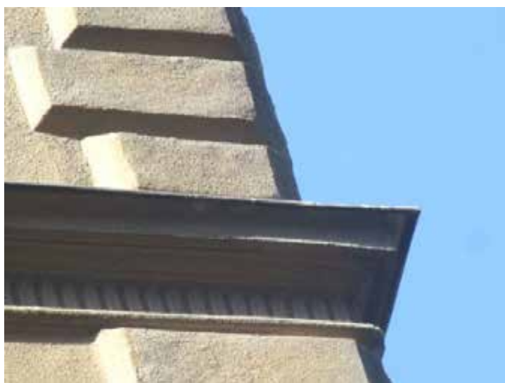
110.-113. Az oldalhomlokzat koronázó főpárkányának és a II. emelt fölötti övpárkányának a részletei – eredeti építéskori, műemléki értékű szerkezetek
