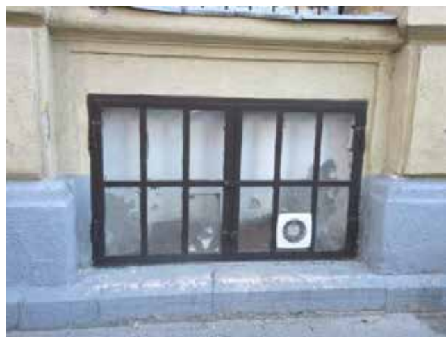
29.-31. Az épület jobb (Ny-i) oldalának földszinti szakasza és a 7. axisban álló ablak és pinceablak részletei – a homlokzat kialakítása építéskori, a földszinti nyílások átalakítottak, az ablakok nyílászárói újak, de a felülvilágítók eredetiek. A lábazat és a vörösmész-kő előlépcsők, valamint a fém pinceablakok építéskoriak. A 6. tengelyben nyitott pincelejárát utólagos
