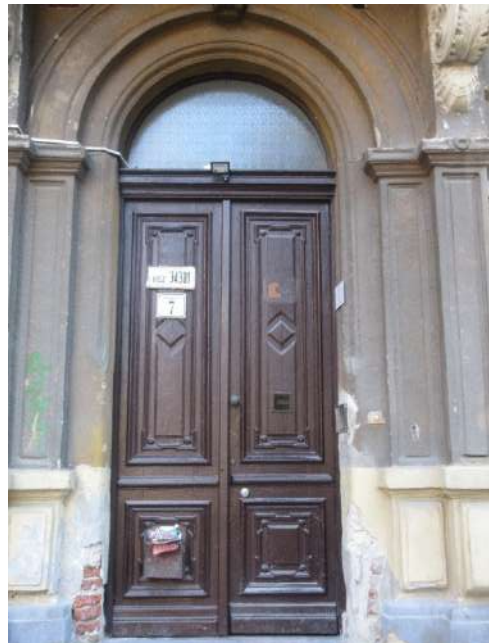
22., 23. A bejárat kapuzat és a bejárat kapu nézetei – a lizénákkal szegélyezett félköríves záradéku kapuzat kialakítása és a félköríves záradéku, felülvilágító, kétszárnyú kapu eredeti építészeti, műemléki értékű szerkezet és nyílászáró
