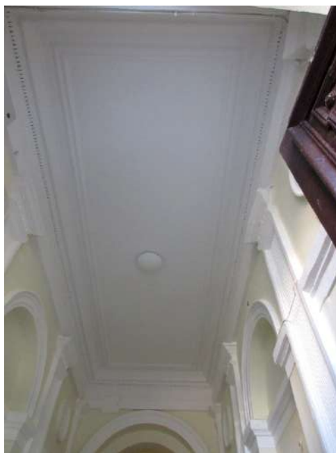
122.,123. A kapualj padozata és mennyezete – a járófelület drappos kerámia lapburkolat új, silány burkolat, a tagozatos, tükrös síkmennyezet építéskori, műemléki értékű elem
