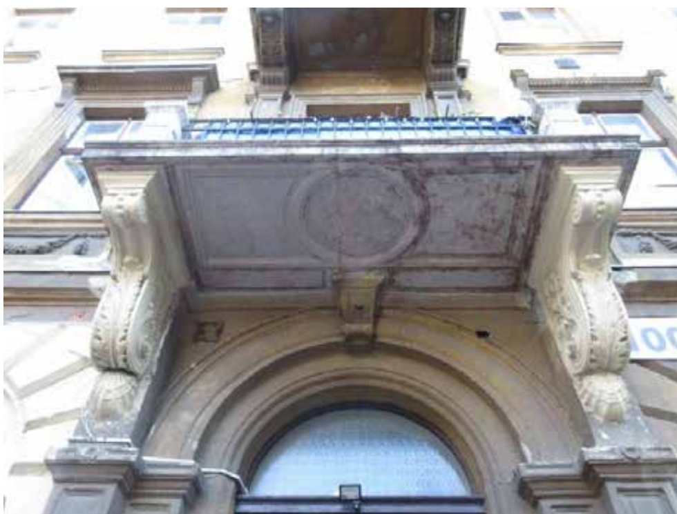
44.,45. A homlokzat középtengelyében elhelyezkedő I. emeleti erkély nézetei – a kagylós-indás-akantuszos díszű, hullámos vonalú konzolokon nyugvó vörösmész-kő lemezes erkély eredeti építéskori, műemléki értékű szerkezet. A kovácsoltvas korlát nem eredeti
