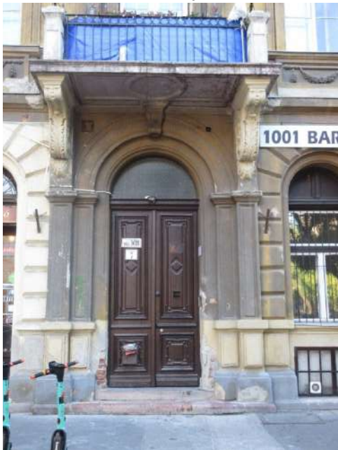
22., 23. A bejárat kapuzat és a bejárat kapu nézetei – a lizénákkal szegélyezett félköríves záradéku kapuzat kialakítása és a félköríves záradéku, felülvilágító, kétszárnyú kapu eredeti építészeti, műemléki értékű szerkezet és nyílászáró
