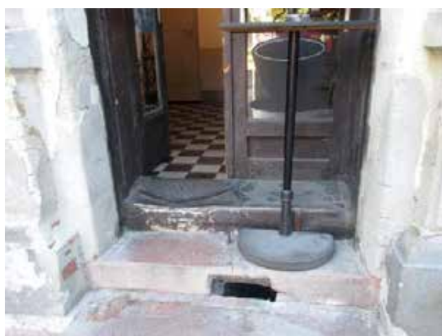
10.-13. Az épület bal (É-i) oldalának földszinti szakasza és a lábazatok, előlépcsők részletei – a homlokzat kialakítása építéskori, a nyílások részben átalakítottak, a nyílászárók újak, a lábazat és a vörösmész-kő előlépcsők építéskoriak. Az előlépcsők elhelyezkedése alapján meghatározhatók az eredeti bejárat nyílások
