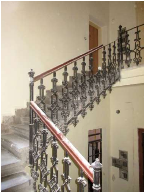
167.-170. A III.emeletre haladó lépcsőkar, a lépcsőforduló és a padlásszintre vezető lépcsőkar nézetei – a lépcső és korlátja eredeti építészeti, műemléki értékű szerkezetek. A lépcsőforduló és a II. emeleti pihenő járófelülete is eredeti építészeti kőlemez, a világítóudvarra néző ablak építészeti
