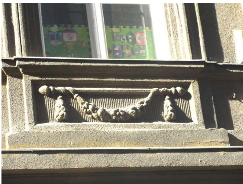
102.,103. I. emeleti ablak tagozati díszítése (szemöldök, parapet) és a nyílászáró részlete – műemléki értékű szerkezet és nyílászáró
