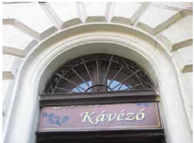
19.,20. A homlokzat 3. axisában elhelyezkedő bejáratú ajtó nézete és az ajtó felülvilágítójának a részlete – a félköríves bejáratú nyílás építéskori kialakítás, a benne lévő ajtó asztalos-szerkezete új. A felülvilágító és a vízszintes tokosztó eredeti szerkezet, a sugaras kiosztású kovácsoltvas rácsozat korabeli szerkezet
