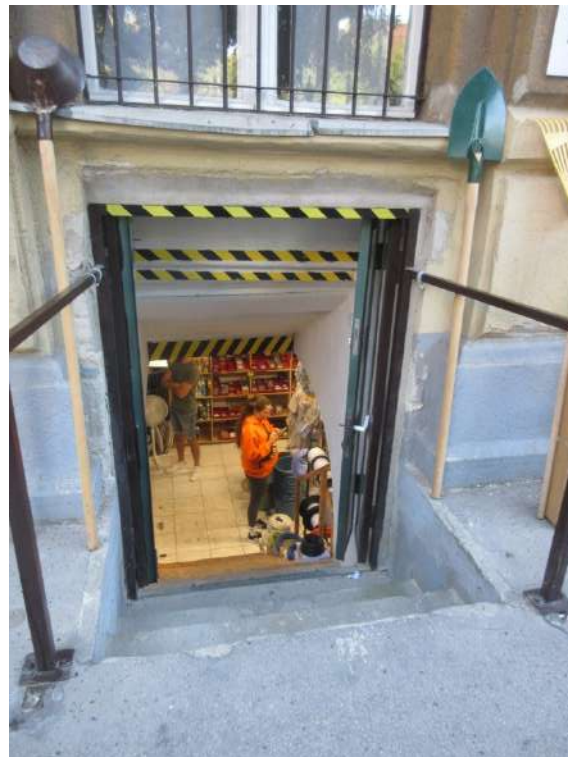
35.,36. A homlokzat 6. tengelyében nyitott pincelejárát – pinceablakból utólagosan kialakított előtetős lejárát, igénytelen, a homlokzat megjelenését kedvezőtlenül befolyásolja
