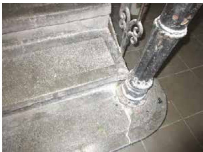
146.-149. A földszintről az I. emeletre haladó lépcsőkar és a félemeleti pihenő nézetei, valamint a képcső részlete – a lépcső eredeti építéskori, műemléki értékű szerkezet, megerősítése és a lépcsőfokok műkő borítása 1962-ben készült. A lépcsőfordulón kőlemez van, a világítóudvarra néző ablak építéskori. A díszes öntöttvas korlátis építéskori, műemléki értékű szerkezet
