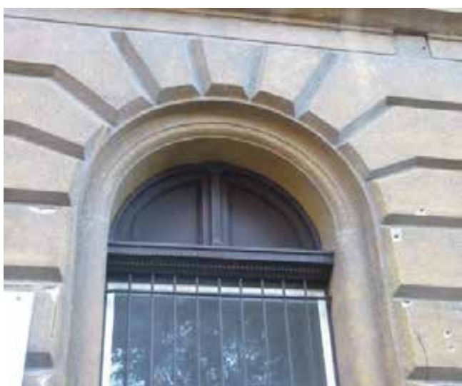
32.-34. Földszinti ablak nézete és részlete – a földszinti ablak vízszintes tokosztója és a félköríves felülvilágító eredeti, az alsó ablakrész új nyílászáró
