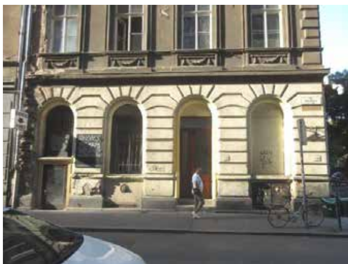
90.-92. A Klauzál utcai oldalhomlokzat emeleti és földszinti szakaszainak nézete – a kisebb átalakítások és a homlokzati tagozatok sérüléseinek ellenére, az épület utcai homlokzatának a megjelenése és kialakítása műemléki érték
