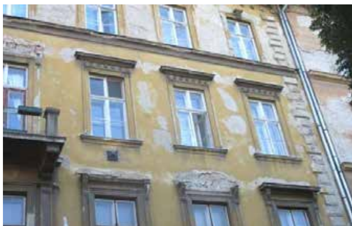
55.-57. A homlokzat II. emeleti szakaszai (ball, közép és jobb) – eredeti építéskori, műemléki értékű nyíláskiosztás és neoreneszánsz tagozati díszítések, kőerkély és korlát kőpillére. A kovácsoltvas korlát már nem eredeti, valószínűleg az 1960-as évek elején történt felújításkor készült
