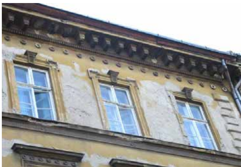
66.-68. A homlokzat III. emeleti szakaszai (ball, közép és jobb) – eredeti építéskori, műemléki értékű nyíláskiosztás és neoreneszánsz tagozati díszítések
