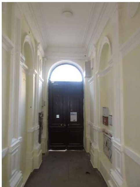
120.,121. A kapualj nézete a lépcsőház és a tér felé - a tükrös kialakítású síkmennyezetes, fejezetes lizénákkal tagolt, stukkódíszes kapualj kialakítása és szerkezete, valamint tagozati díszítései 1874-ben készült, műemléki értékű szerkezetek és díszítőelemek
