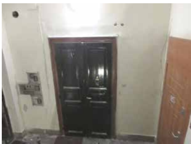
163.-166. A II. emeleti pihenőn elhelyezkedő lakásbejáratok és a pihenő felülnézete – a pihenő két oldaláról nyíló egyszárnyú lakásbejáratok új, igénytelen nyílászárók, csak a középső, ÉNy-i falon álló kétszárnyú ajtó nyílása és nyílászárója eredeti építéskori
