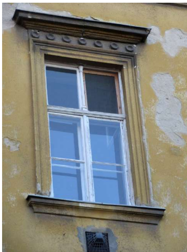
64.,65. II. emeleti új és régi homlokzati ablak – a homlokzat II. emeletének 1 és 2 tengelyében új ablakok vannak, a többi tengelyben még meg vannak az eredeti építéskori, műemléki értékű nyílászárók
