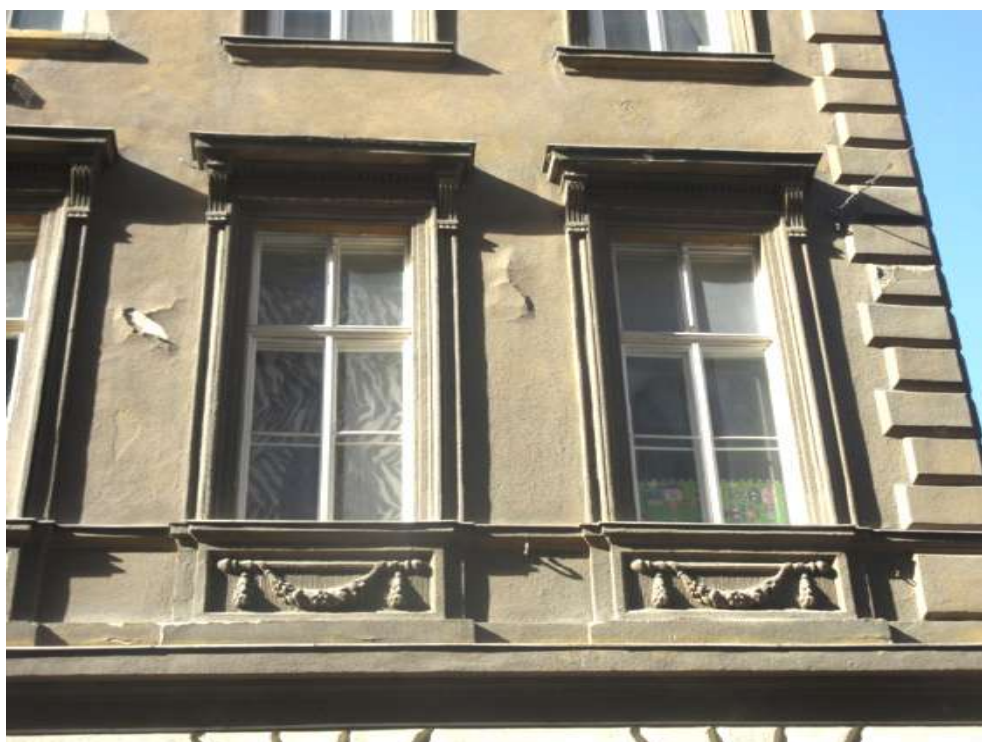
100.,101. Az I. emeleti oldalhomlokzat bal és jobb oldali szakasza - eredeti építéskori, műemléki értékű nyíláskiosztás és neoreneszánsz tagozati díszítések, valamint homlokzati nyílászárók
