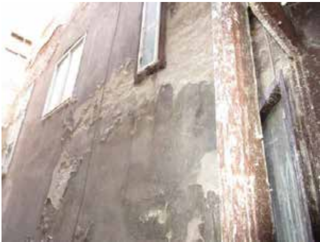
184.,185. A belső udvari homlokzat részletei – építéskori falszerkezet, építéskori és új nyílászárók vegyesen
