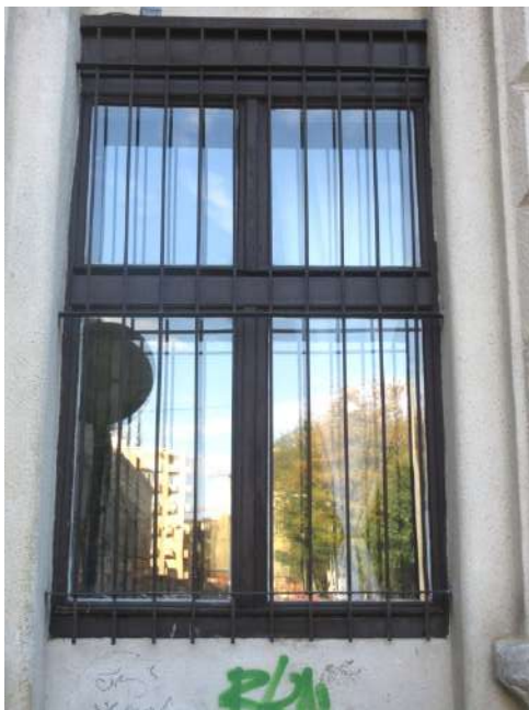
14.-16. A homlokzat 1 tengelyében álló ablaknyílás és nyílászárójának részletei – az egykori bejárati nyílás parapetét 1978-ban felfalazták, az ablak nyílászárója és a rács új
