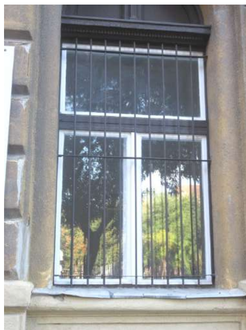
32.-34. Földszinti ablak nézete és részlete – a földszinti ablak vízszintes tokosztója és a félköríves felülvilágító eredeti, az alsó ablakrész új nyílászáró
