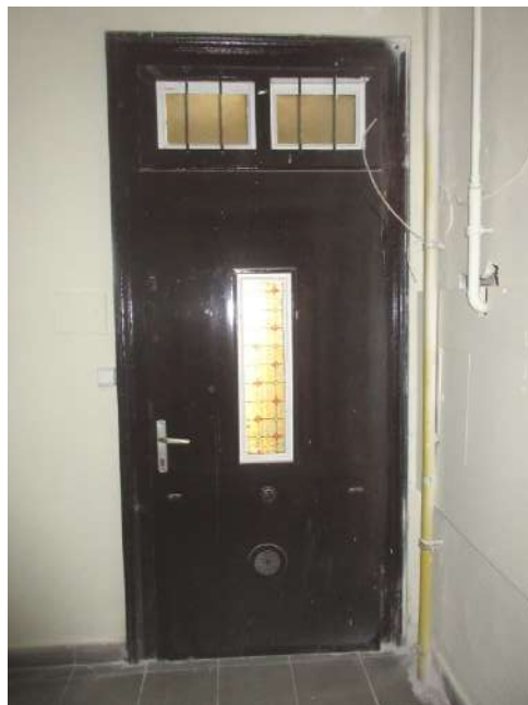
140.-143. A lépcsőház földszinti pihenőjén elhelyezkedő ajtók - az ÉK-i oldalfalon lévő, Klauzál utcai üzletbe nyíló egyszárnyú fa ajtó építéskori nyílászáró, a DNy-i falon lévő egyszárnyú fa ajtó és a világítóudvarba vezető fém ajtó új nyílászárók
