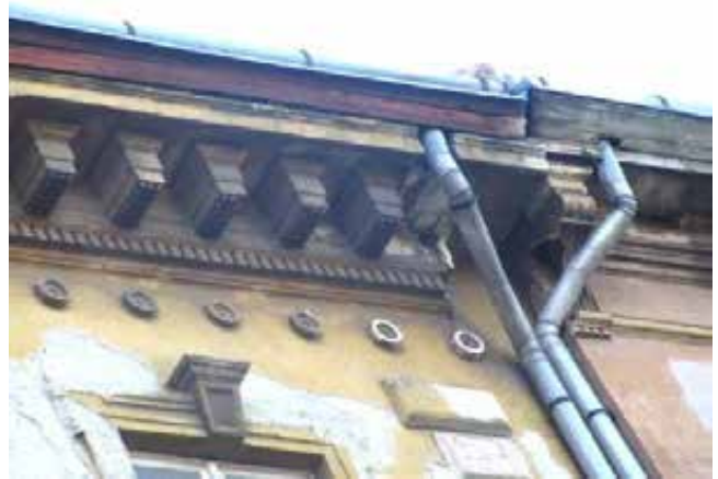
80.-83. A koronázó főpárkány részletei – a fogrovatsoros, cseppdíszes tagolt konzolokkal díszített főpárkány és az alatta futó tárcsa-díszsor eredeti építéskori, műemlékű értékű szerkezet
