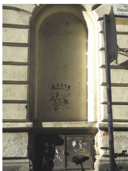
95.-99. Az 1., 2. 3. és 4. tengelyben elhelyezkedő földszinti nyílások és nyílászárók részlete – a félköríves záradéku nyílásokat folyamatosan átalakították, hol ajtóként, hol ablakként használták. A pincelejárat eredeti, de a benne lévő ajtó új, a 2. és 3. axisban álló ablak és ajtó is új nyílászáró
