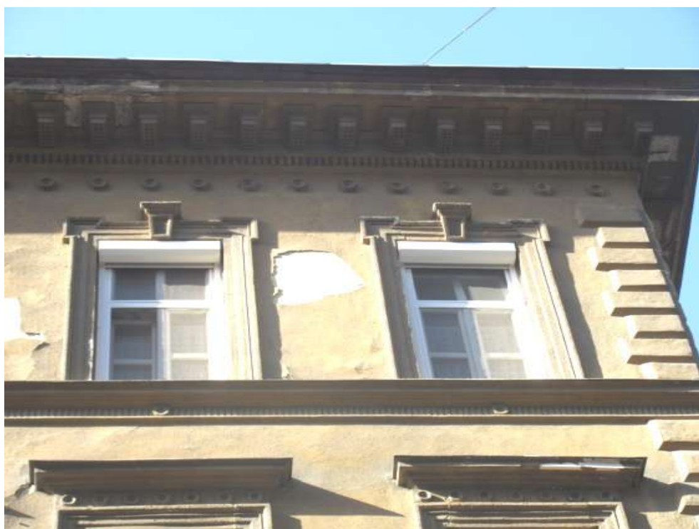
108.,109. A III. emeleti oldalhomlokzat bal és jobb oldali szakasza - eredeti építéskori, műemléki értékű nyíláskiosztás és neoreneszánsz tagozati díszítések. Az ablakok nyílászárói újak
