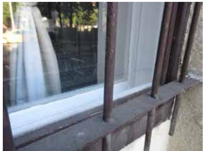
14.-16. A homlokzat 1 tengelyében álló ablaknyílás és nyílászárójának részletei – az egykori bejárati nyílás parapetét 1978-ban felfalazták, az ablak nyílászárója és a rács új
