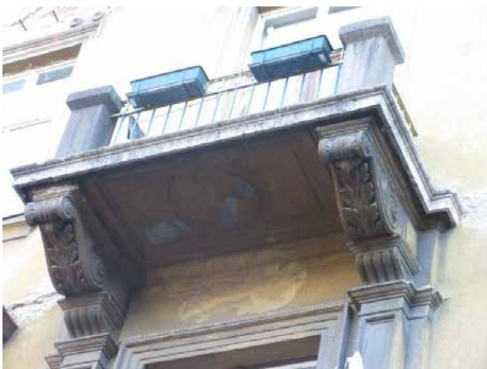
62.,63. A homlokzat középtengelyében elhelyezkedő II. emeleti erkély nézetei – az akantuszleveles konzolokon nyugvó vörösmészkő lemezes erkély eredeti építéskori, műemléki értékű szerkezet. A korlát kőpillérei eredetiek, de a kovácsoltvas korlát újabb szerkezet
