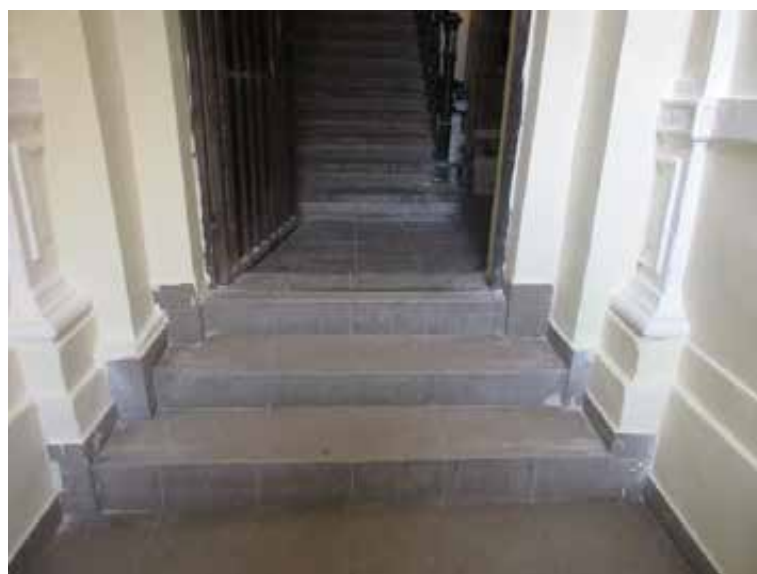
132.,133. A kapualj DK-i oldalfala a lépcsőházba vezető nyílással és az előlépcső – a lizénákkal által határolt félköríves záradékú ajtónyílás eredeti építéskori kiképzés. A kapualjból a lépcsőházi szintre vezető lépcső is építéskori, de a lépcsőfokok jelenlegi kerámia lapburkolat új, igénytelen burkolat. A fémrácsos ajtó is új, igénytelen nyílászáró
