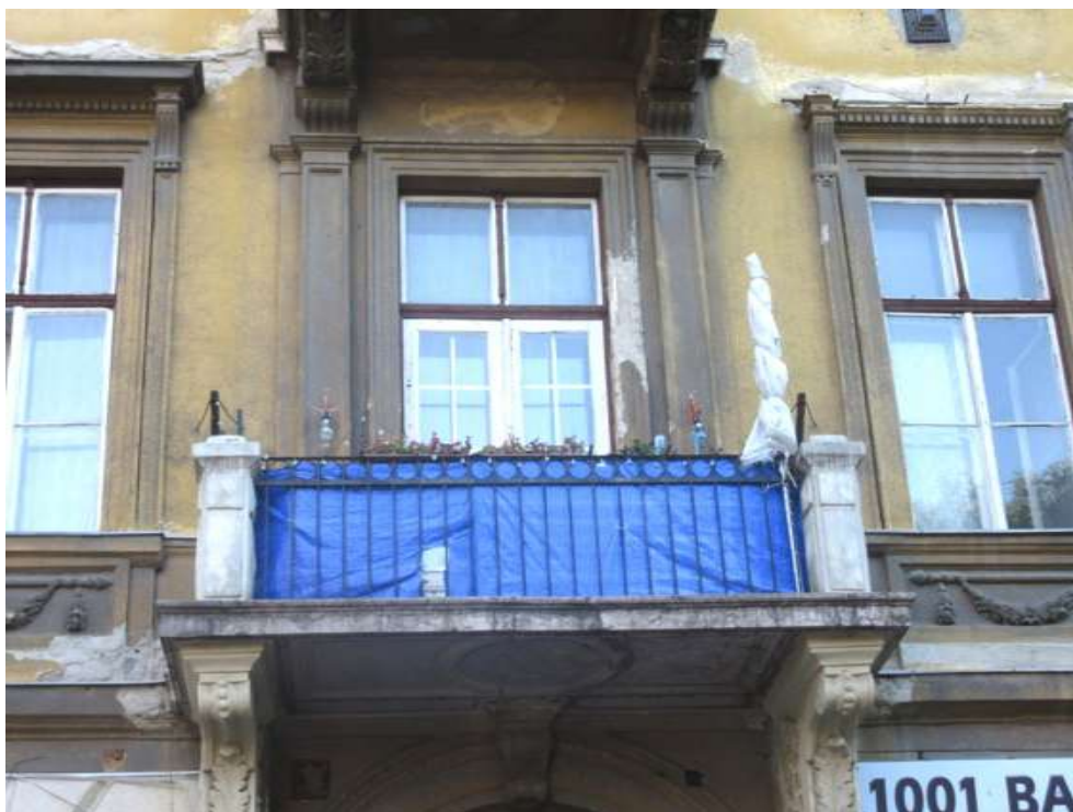
52. Az I. emeleti erkély erkélyajtója – a kétszárnyú ajtó felülvilágítója eredeti építéskori nyílászáró, de az alsó ajtószárnyak újak
