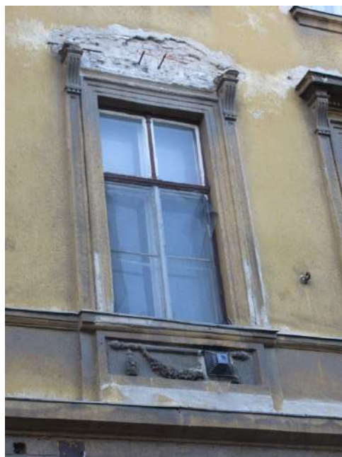
53.,54. I. emeleti ablakok és a 6. axisban elhelyezkedő ablak nézete – az ablaknyílások tagozati díszítései és a nyílászárók eredeti építéskori, műemléki értékű szerkezetek. Az utólagosan felszerelt, előregyártott szemöldökdíszek több helyen sérültek vagy hiányoznak
