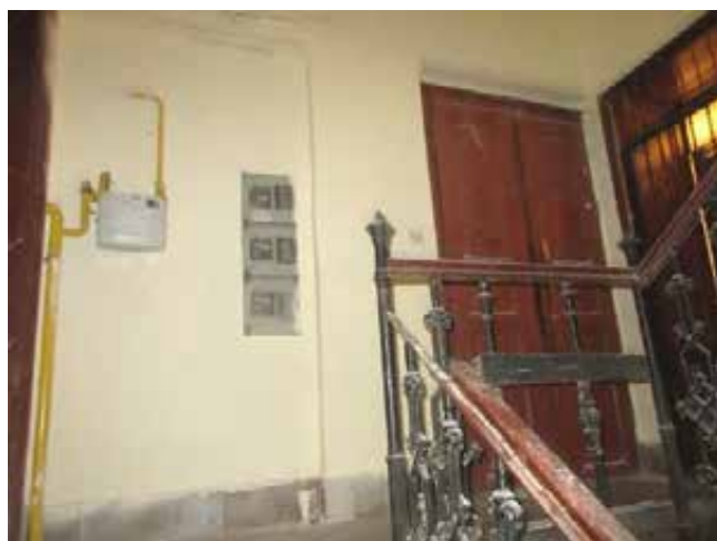
150.-153. Az I.emeletre haladó lépcsőkar és az I. emeleti pihenő nézetei – a lépcső és korlátja eredeti építéskori, műemléki értékű szerkezetek. Az I. emeleti pihenő járófelülete is eredeti építéskori kőlemez, a kétszárnyú lakásbejárati ajtó építéskori nyílászáró
