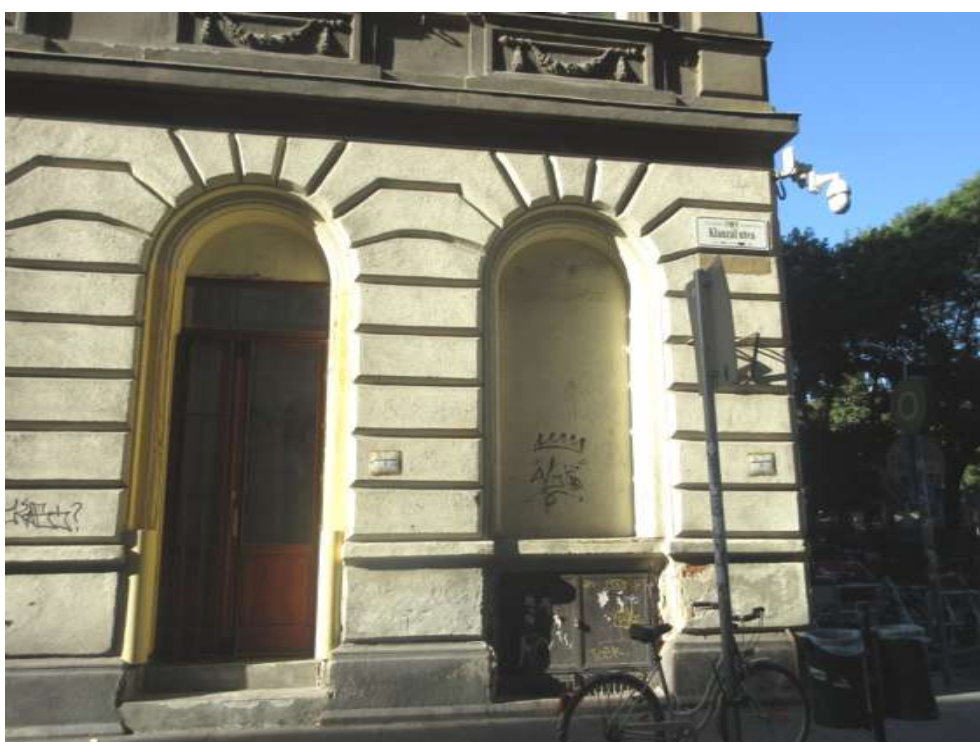
93.,94. Az oldalhomlokzat 1-2 és 3-4 tengelyének földszinti szakaszai – eredeti építéskori kialakítás a nyílások újabb-kori átalakításával
