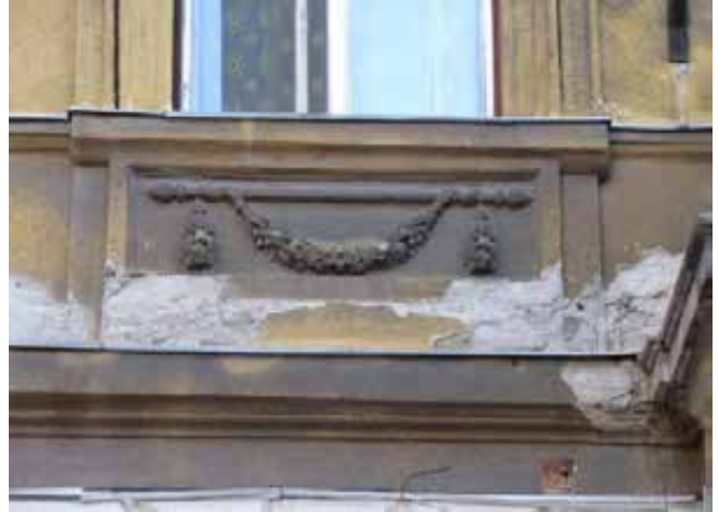
40.-43. Az I. emelet 3 tengely ablakának nézete és részletei – a tagozatos szalagkeretben álló, füzérdíszes parapetre támaszkodó, konzolokkal támasztott szemöldökdíszes ablaknyílás és a benne lévő fa nyílászáró eredeti építéskori, műemléki értékű elemek
