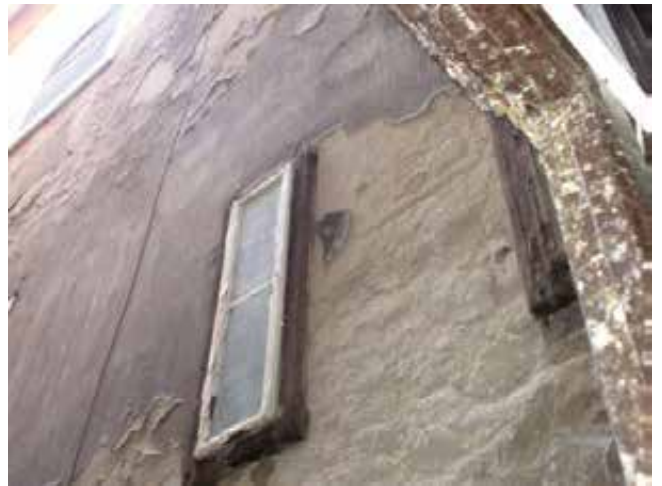
184.,185. A belső udvari homlokzat részletei – építéskori falszerkezet, építéskori és új nyílászárók vegyesen
