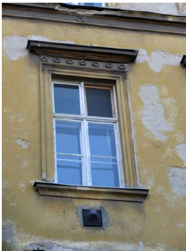
59.-61. II. emeleti ablakok nézetei – az ablaknyílások tagozati díszítései és a nyílászárók eredeti építéskori, műemléki értékű szerkezetek. Az utólagosan felszerelt, építéskori előregyártott szemöldökdíszek több helyen sérültek vagy hiányoznak
