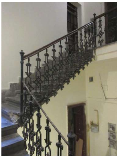
158.-162. A II. emeletre haladó lépcsőkar, a lépcsőforduló és a II. emeleti pihenő nézetek – a lépcső és korlátja eredeti építéskori, műemléki értékű szerkezetek. A lépcsőforduló és a II. emeleti pihenő járófelülete is eredeti építéskori kőlemez, a világítóudvarra néző ablak építéskori
