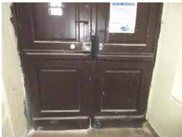
114.-119. A bejárat kapu külső és vbelső nézete, valamint belső részletei – a félköríves záradékú, felülvilágító kétszárnyú bejárat kapu asztalos-szerkezete építéskori, műemléki értékű szerkezet. A kapu vasalatai részben újak, csak a belső Ny-i oldalon maradt meg az eredeti diópánt
