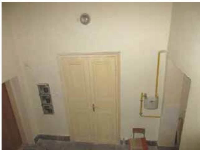
171.-174. A III. emeleti pihenőn elhelyezkedő lakásbejárati ajtók és a pihenő felülnézete – a pihenő két oldaláról nyíló egyszárnyú lakásbejárati ajtók új, igénytelen nyílászárók, csak a középső, ÉNy-i falon álló kétszárnyú ajtó nyílása és nyílászárója eredeti építéskori
