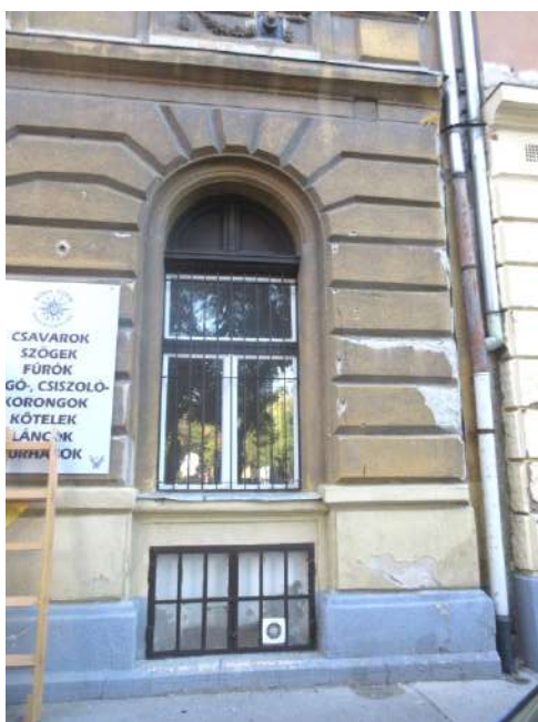
29.-31. Az épület jobb (Ny-i) oldalának földszinti szakasza és a 7. axisban álló ablak és pinceablak részletei – a homlokzat kialakítása építéskori, a földszinti nyílások átalakítottak, az ablakok nyílászárói újak, de a felülvilágítók eredetiek. A lábazat és a vörösmész-kő előlépcsők, valamint a fém pinceablakok építéskoriak. A 6. tengelyben nyitott pincelejárát utólagos
