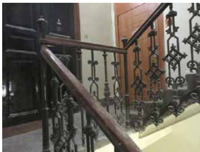
158.-162. A II. emeletre haladó lépcsőkar, a lépcsőforduló és a II. emeleti pihenő nézetek – a lépcső és korlátja eredeti építéskori, műemléki értékű szerkezetek. A lépcsőforduló és a II. emeleti pihenő járófelülete is eredeti építéskori kőlemez, a világítóudvarra néző ablak építéskori
