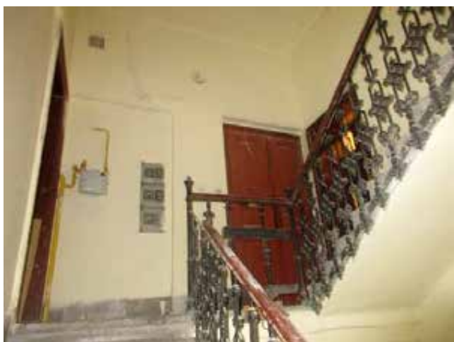
150.-153. Az I.emeletre haladó lépcsőkar és az I. emeleti pihenő nézetei – a lépcső és korlátja eredeti építéskori, műemléki értékű szerkezetek. Az I. emeleti pihenő járófelülete is eredeti építéskori kőlemez, a kétszárnyú lakásbejárati ajtó építéskori nyílászáró
