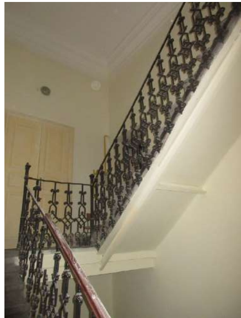
167.-170. A III.emeletre haladó lépcsőkar, a lépcsőforduló és a padlásszintre vezető lépcsőkar nézetei – a lépcső és korlátja eredeti építészeti, műemléki értékű szerkezetek. A lépcsőforduló és a II. emeleti pihenő járófelülete is eredeti építészeti kőlemez, a világítóudvarra néző ablak építészeti
