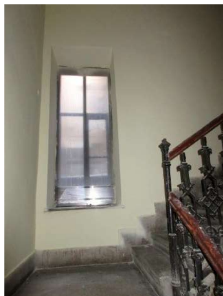
146.-149. A földszintről az I. emeletre haladó lépcsőkar és a félemeleti pihenő nézetei, valamint a képcső részlete – a lépcső eredeti építéskori, műemléki értékű szerkezet, megerősítése és a lépcsőfokok műkő borítása 1962-ben készült. A lépcsőfordulón kőlemez van, a világítóudvarra néző ablak építéskori. A díszes öntöttvas korlátis építéskori, műemléki értékű szerkezet
