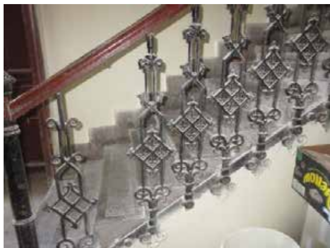
134.-139. A lépcsőház földszinti pihenőjéről induló lépcsőkar nézetei és a lépcsőfokok és korlát részletei – a háromkarú, mészke szerkezetű, de műke burkolatos, díszes öntöttvas korláttal határolt lépcső szerkezete és korlátja eredeti építéskori, műemléki értékű elem
