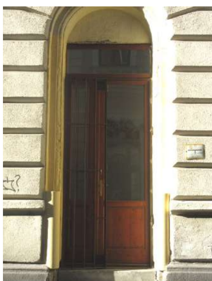
95.-99. Az 1., 2. 3. és 4. tengelyben elhelyezkedő földszinti nyílások és nyílászárók részlete – a félköríves záradéku nyílásokat folyamatosan átalakították, hol ajtóként, hol ablakként használták. A pincelejárat eredeti, de a benne lévő ajtó új, a 2. és 3. axisban álló ablak és ajtó is új nyílászáró
