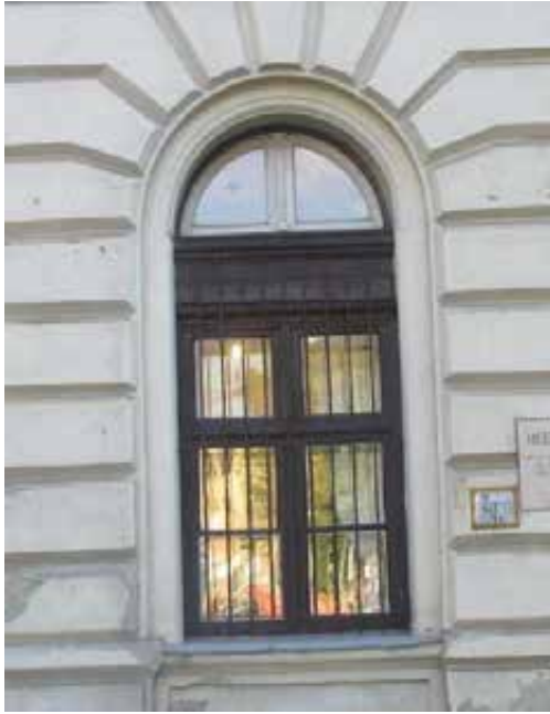
17.,18. A homlokzat 2 tengelyében álló földszinti ablak és pinceablak nézete – a földszinti ablak és pinceablak nyílása eredeti építéskori. A földszinti ablak vízszintes tokosztójának a felső része és a félköríves felülvilágító eredeti, az alsó ablakrész új nyílászáró. A fémszerkezetes pinceablak is korabeli szerkezet
