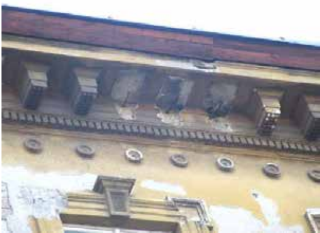
80.-83. A koronázó főpárkány részletei – a fogrovatsoros, cseppdíszes tagolt konzolokkal díszített főpárkány és az alatta futó tárcsa-díszsor eredeti építéskori, műemlékű értékű szerkezet
