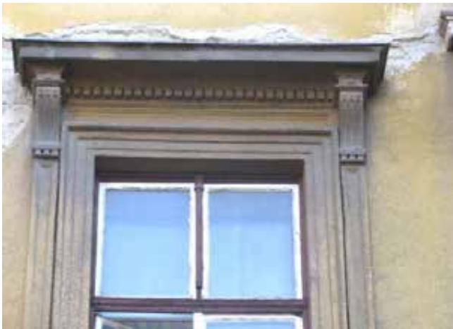
40.-43. Az I. emelet 3 tengely ablakának nézete és részletei – a tagozatos szalagkeretben álló, füzérdíszes parapetre támaszkodó, konzolokkal támasztott szemöldökdíszes ablaknyílás és a benne lévő fa nyílászáró eredeti építéskori, műemléki értékű elemek
