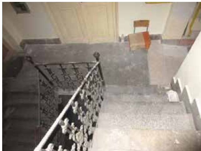
171.-174. A III. emeleti pihenőn elhelyezkedő lakásbejárati ajtók és a pihenő felülnézete – a pihenő két oldaláról nyíló egyszárnyú lakásbejárati ajtók új, igénytelen nyílászárók, csak a középső, ÉNy-i falon álló kétszárnyú ajtó nyílása és nyílászárója eredeti építéskori
