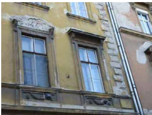
53.,54. I. emeleti ablakok és a 6. axisban elhelyezkedő ablak nézete – az ablaknyílások tagozati díszítései és a nyílászárók eredeti építéskori, műemléki értékű szerkezetek. Az utólagosan felszerelt, előregyártott szemöldökdíszek több helyen sérültek vagy hiányoznak
