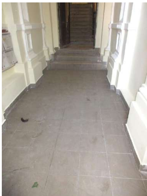
122.,123. A kapualj padozata és mennyezete – a járófelület drappos kerámia lapburkolat új, silány burkolat, a tagozatos, tükrös síkmennyezet építéskori, műemléki értékű elem
