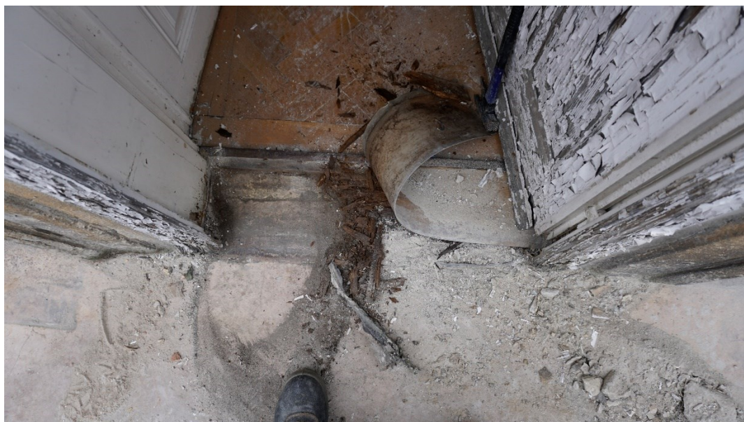
8. kép – 2. emeleti küszöb korhadt maradványa felszedve, alatta látható az erkélykonzol 15 cm mély bekötése
