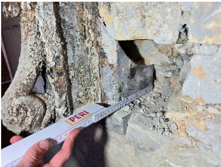
1. kép – 1. emeleti vaskonzol alsó szegmens feltámaszkodása vaslapra, 15 cm felfekvéssel, hátra kötésnek nincsen nyoma (készítette: Nagy Statika Kft.)
