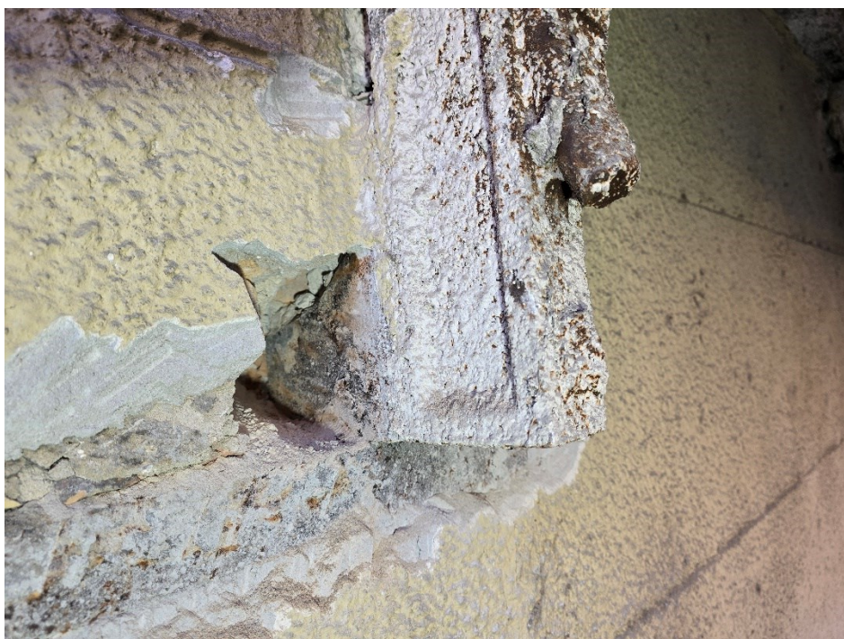
4. kép – 1. emelet, középső erkélyeken vaskonzol bekötése és geometriája szélsőkkel azonos
