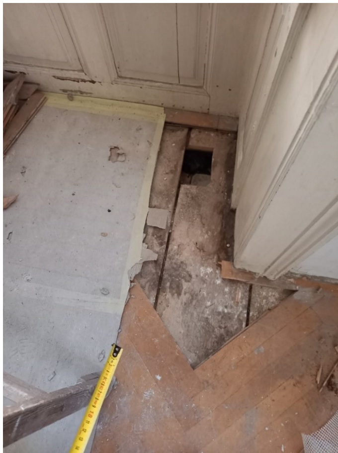
5. kép – roncsolásos kutatás 1. emelet, bal erkély helyzetében
