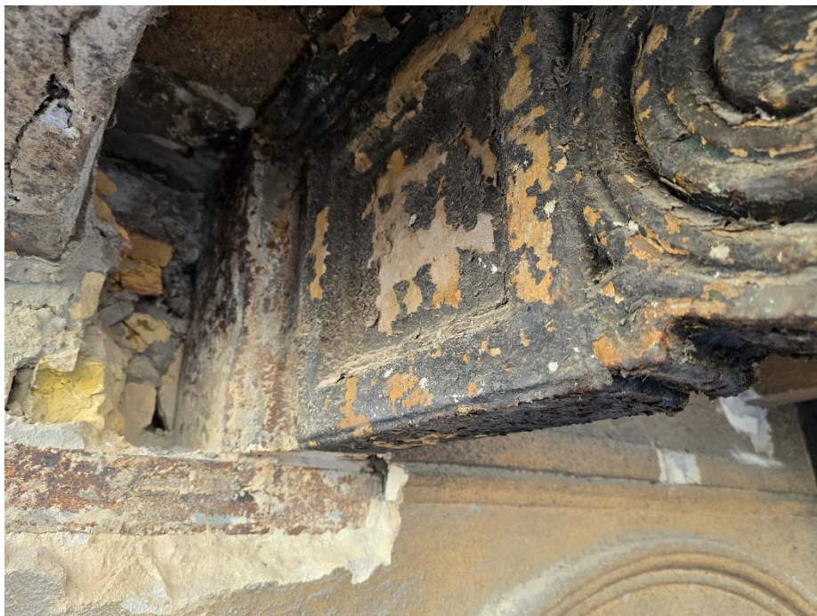
3. kép – 2. emeleti vaskonzol feltámaszkodása vaslapra, hátrakötésnek nincsen nyoma (készítette: Nagy Statika Kft.)
